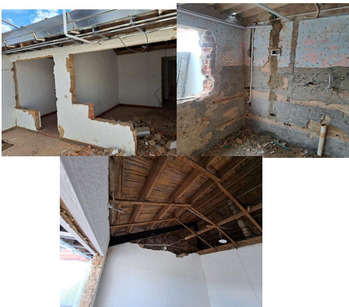
Figura 7 Preliminares de obra, actividades de desmonte y demolición.
