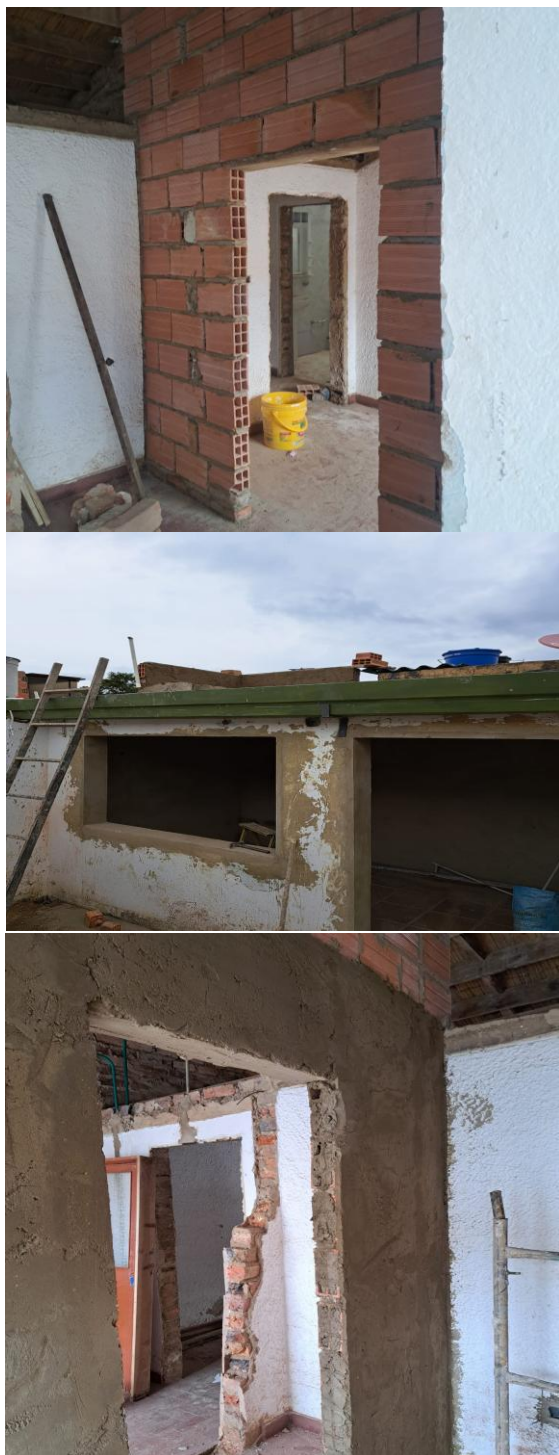
Figura 8 Obra gris. Mampostería y pañete de muros
