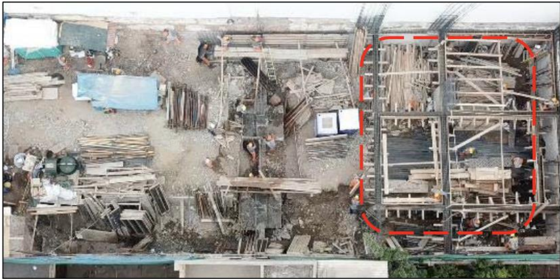
Figura 1 Obra Santa Sofía vuelo dron 05 marzo.
