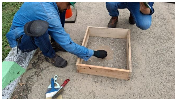
Ilustración 20. Registro fotográfico ensayo del cono de arena
