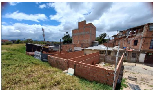
Fotografía 23. Construcción en curso Ronda Quebrada Santa Librada
