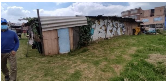
Fotografía 3. Ocupación Ronda de la quebrada Yomasa
