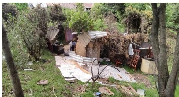
Fotografía 6. Ocupación Quebrada Santa Librada
