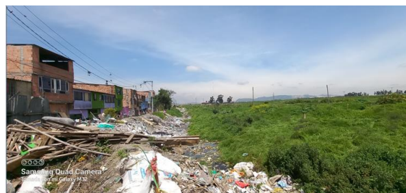
Fotografía 20. Demoliciones Obras Ronda Rio Tunjuelo
