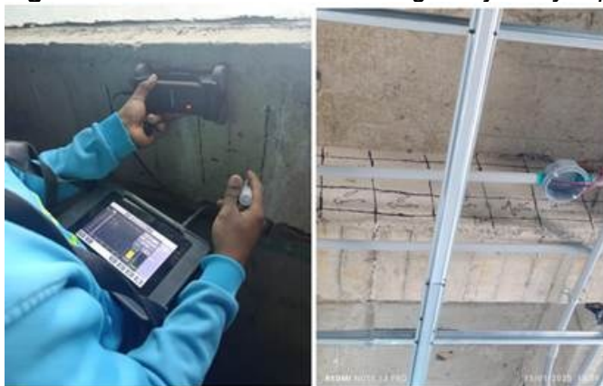
Figura 6. Escáner de elementos viga 2 ejes B y E piso 2
