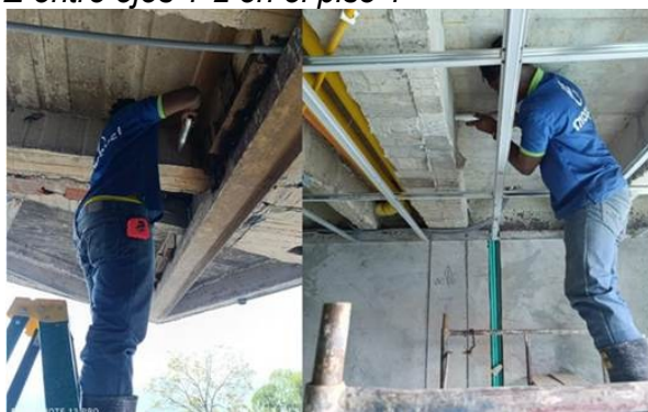
Figura 4. Toma de esclerometrías en la viga en voladizo entre ejes A y B en el piso 2 y la viga E entre ejes 1-2 en el piso 1
