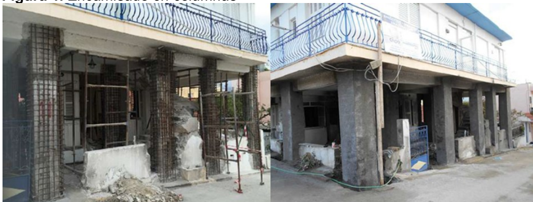
Figura 1. Encamisado en columnas
