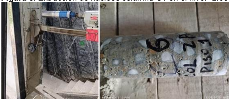
Figura 5. Extracción de núcleos columna C1 en el nivel -2.65
