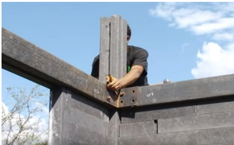
5.10.5. Figura 16. Sistema de Acople con Platina Metálica y Pernos
