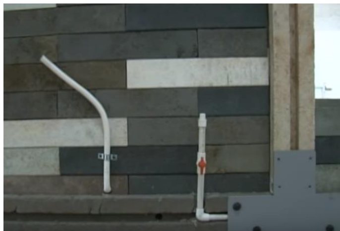
5.10.7. Figura 18. Con el uso de la columna universal se facilita la instalación de las redes eléctricas e hidráulicas.
