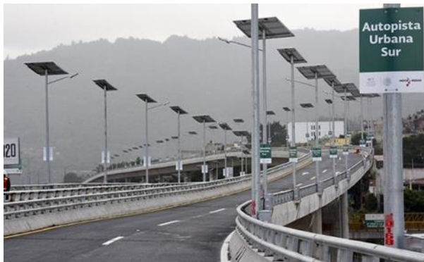
Figura 11. Peaje Autopista Urbana Sur, Ciudad de México
