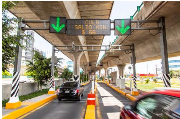
Figura 13. Peaje Viaducto Elevado Bicentenario, Ciudad de México
