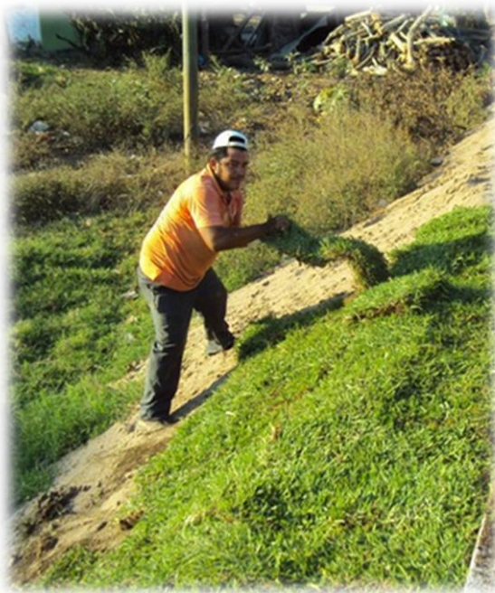
Ilustración 1: Colocación de pastos en los taludes de las vías
