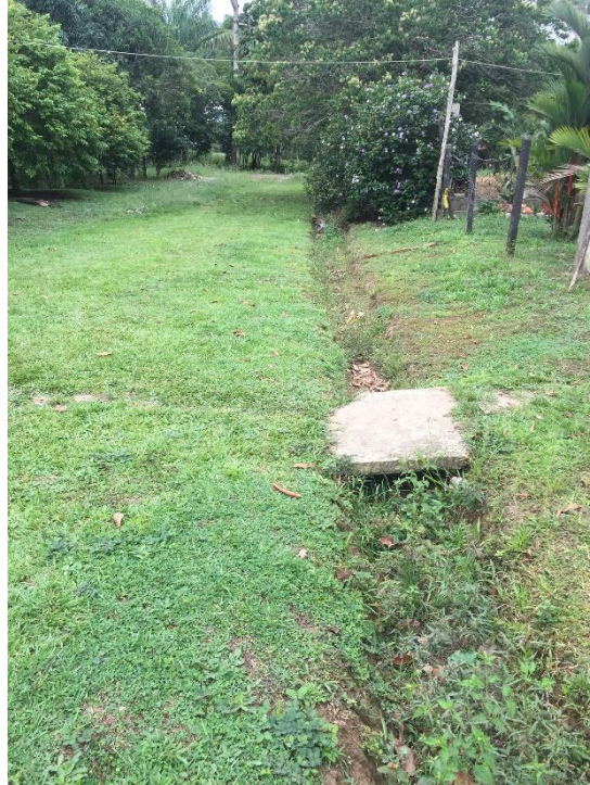
Figura 2. Zanjas de aguas lluvias. Fuente: Elaboración propia.
