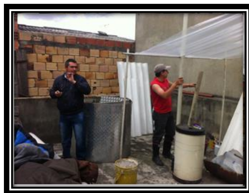
Imagen 18. Construcción cubierta plástica
