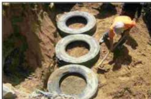
Figura 12 Conformación y Nivelación del Terreno
