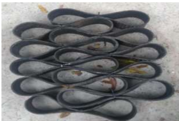
Figura 4: Proceso de armado de geoceldas
