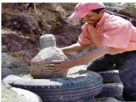
Figura 14 Relleno y Compactación de Llantas
