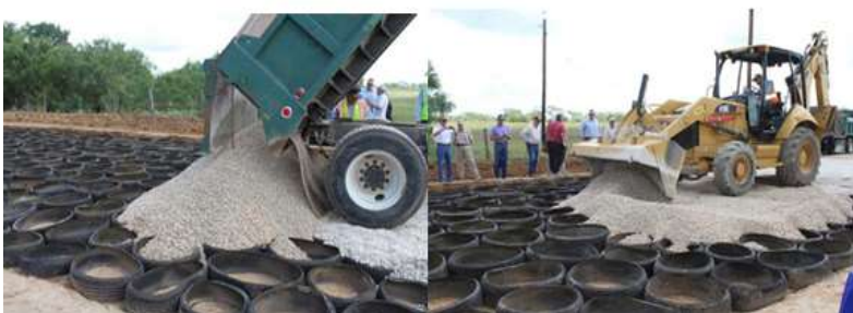
Figura 8: Colocación de material de relleno.
