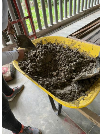
Figura 38. Mezcla con la consistencia deseada
