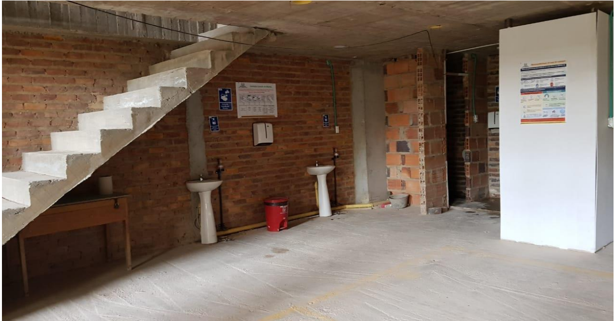
Imagen 5. Adecuaciones en obra, lavamanos y baños.
