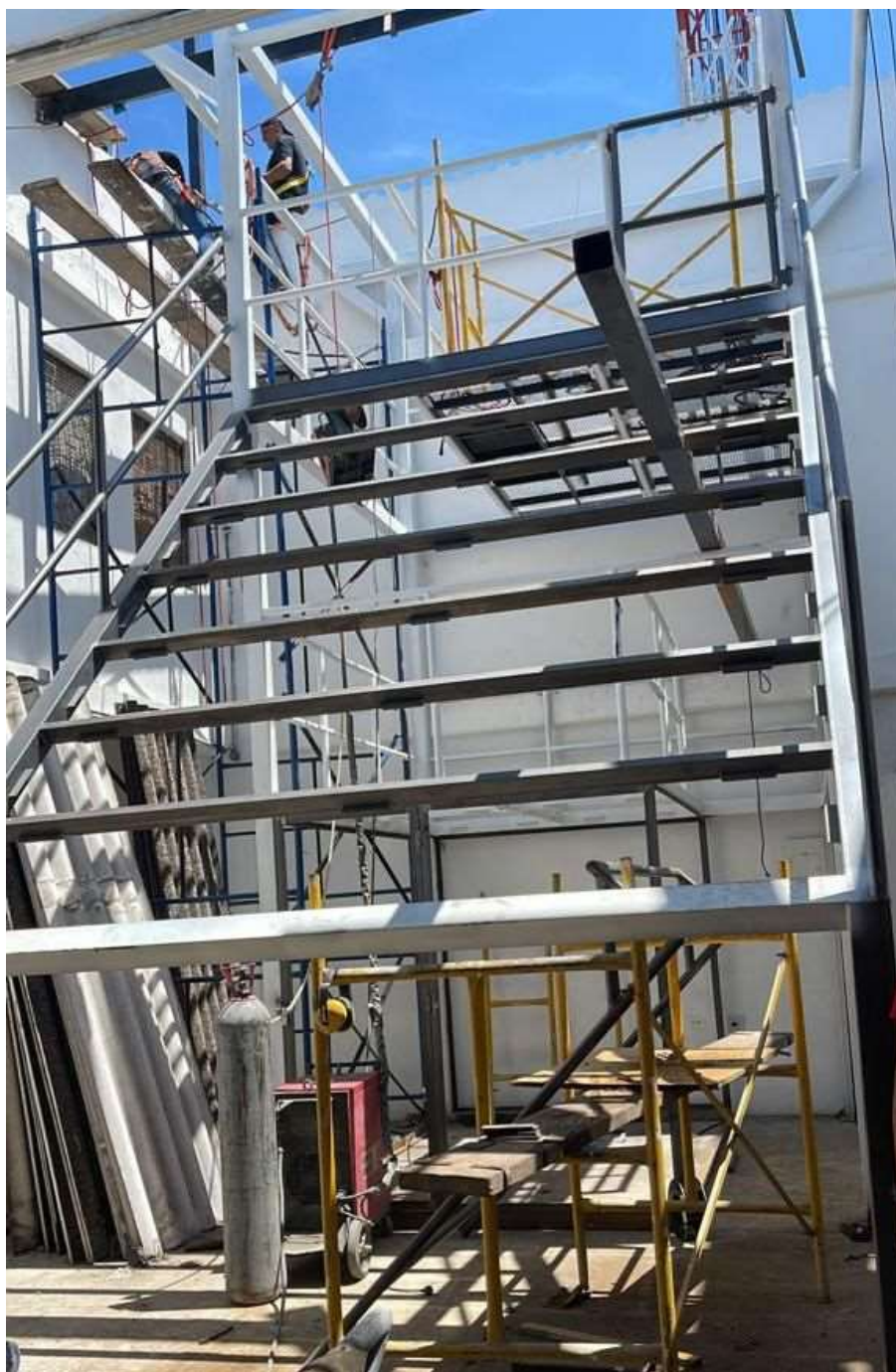
Figura 14 Retiro de cubierta de la bodega para la instalación de Estructura de entrenamiento
