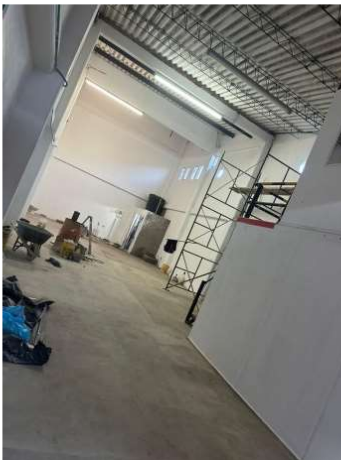
Figura 10 Remodelación de las instalaciones del Centro de Reentrenamiento
