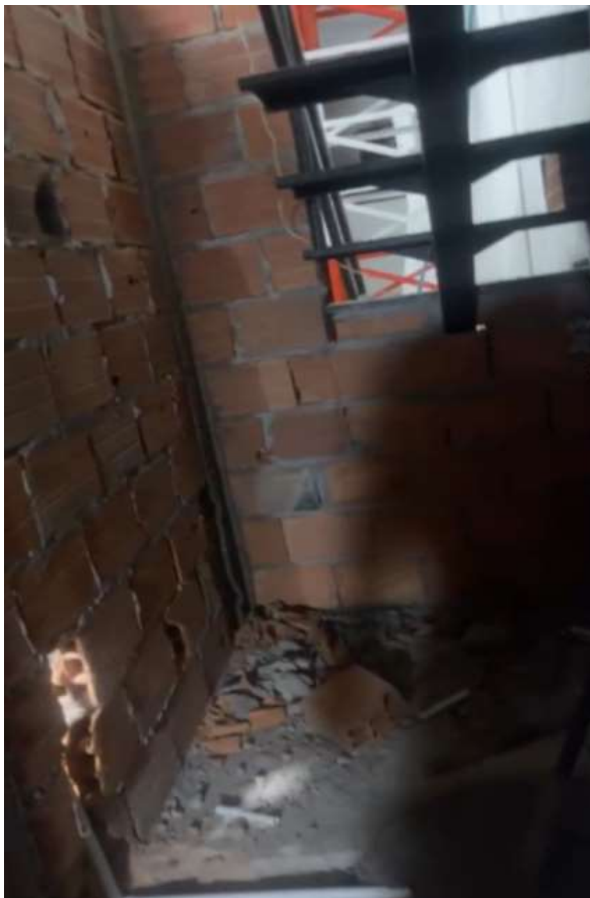
Figura 23 Construcción de unidades sanitarias
