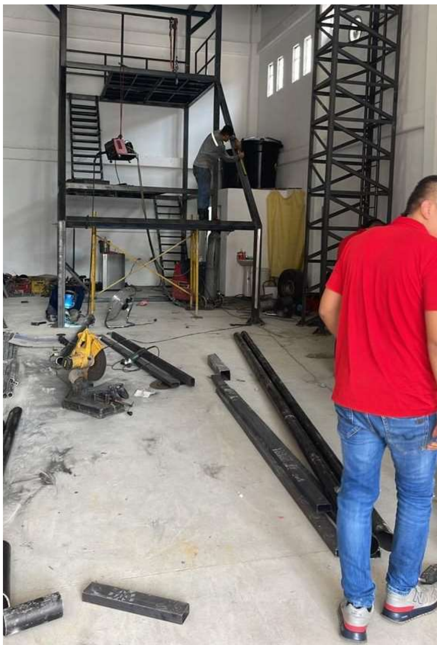
Figura 16 Armado de la estructura lateral
