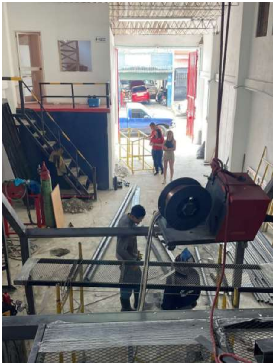
Figura 13 Instalación de Estructura de entrenamiento
