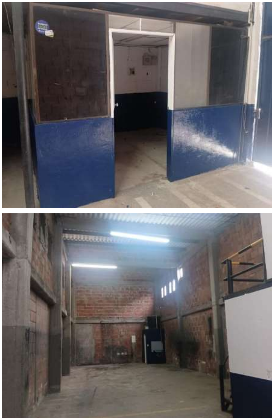
Figura 8 Condiciones internas de la bodega
