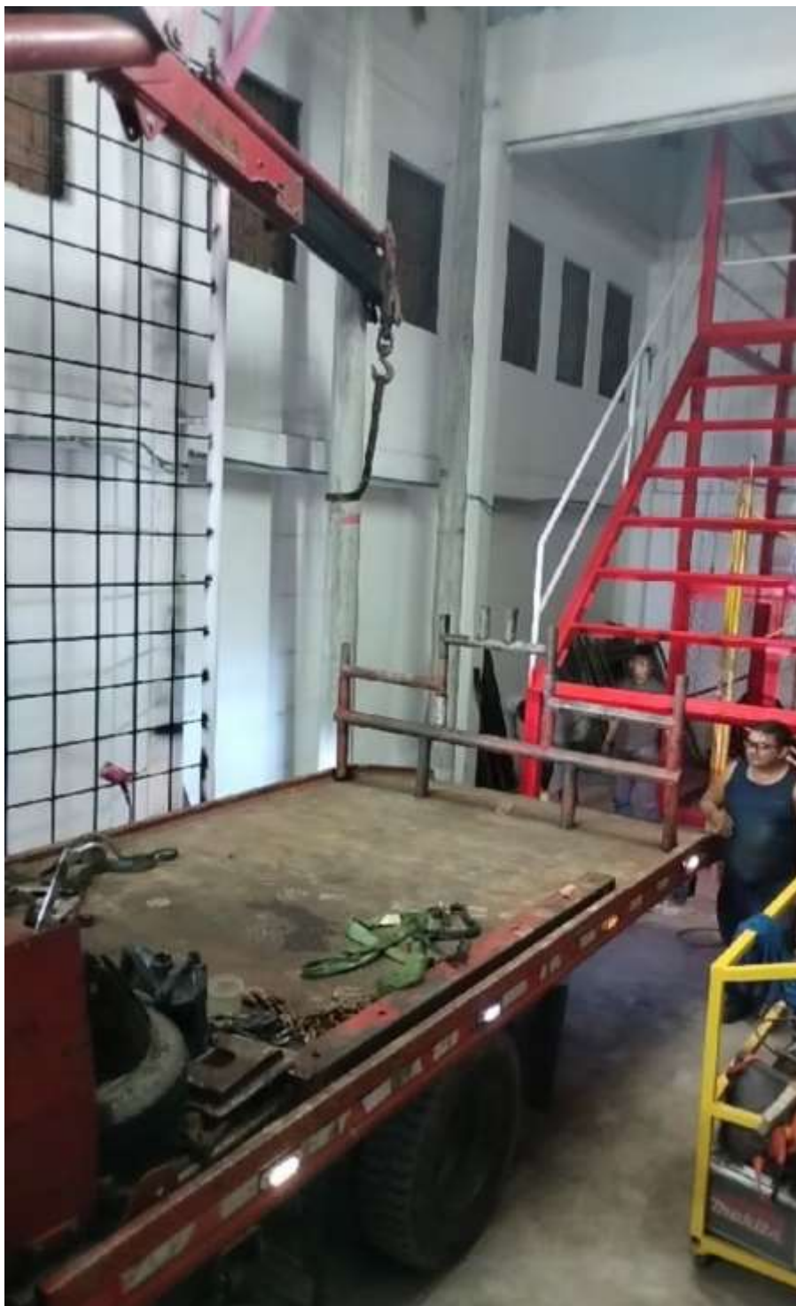
Figura 19 Instalación elementos eléctricos
