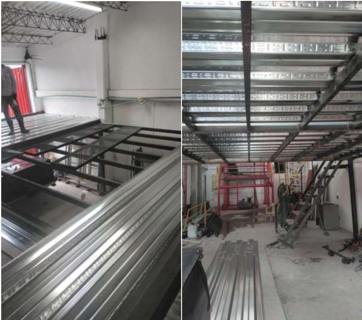
Figura 21 Montaje de estructuras
