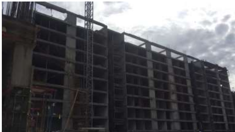
Figura 6. Fachada principal sistema estructural en construcción torre 1 urbanización San Francisco
