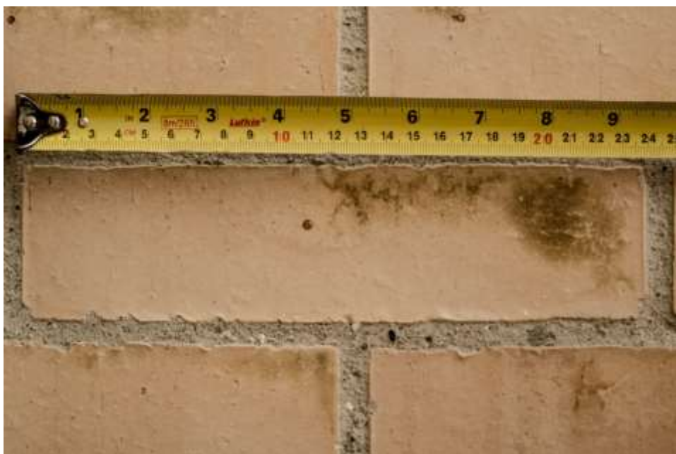
Figura 19. Ladrillo ubicado en fachada torre 1 piso 1
