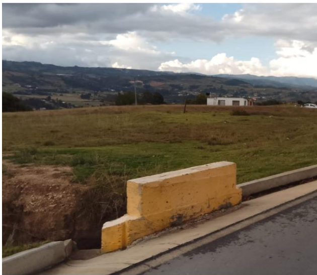
Figura. 14. Imagen obra drenaje 2
