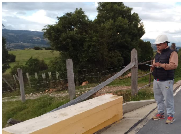
Figura. 13 Imagen obra drenaje1
