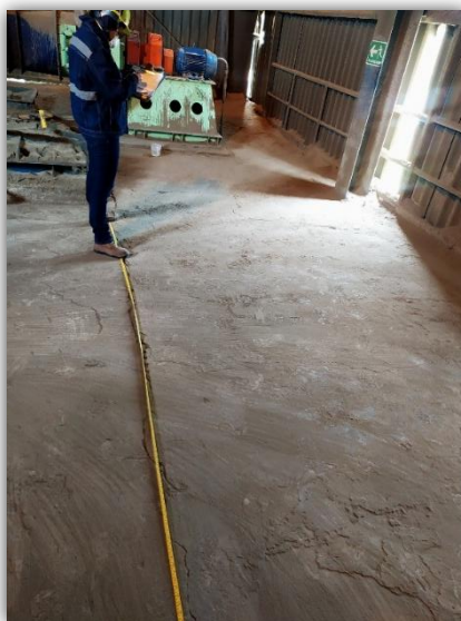
Figura 21: Seguimiento y mediciones a patología hallada en placa de entrepiso del edificio de molienda de cemento.
