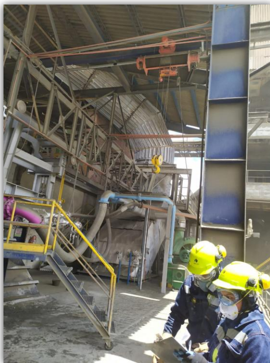
Figura 20: Inspección al proceso de horno rotatorio
