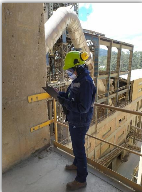
Figura 12: Inspección visual a proceso de almacenamiento de Torre de precalentamiento.
