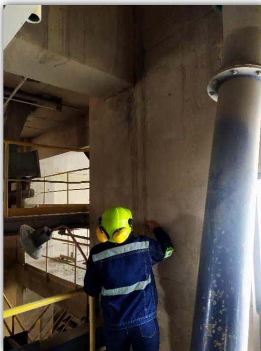
Figura 14: Inspección visual a proceso de almacenamiento de Molienda de crudo.
