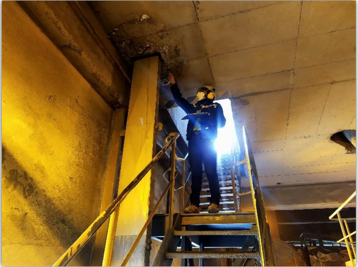
Figura 24: Inspección presencia de carbonatación en placa.
