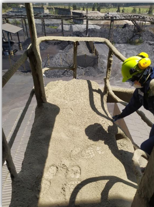
Figura 11: Inspección visual a proceso de almacenamiento de Clinker
