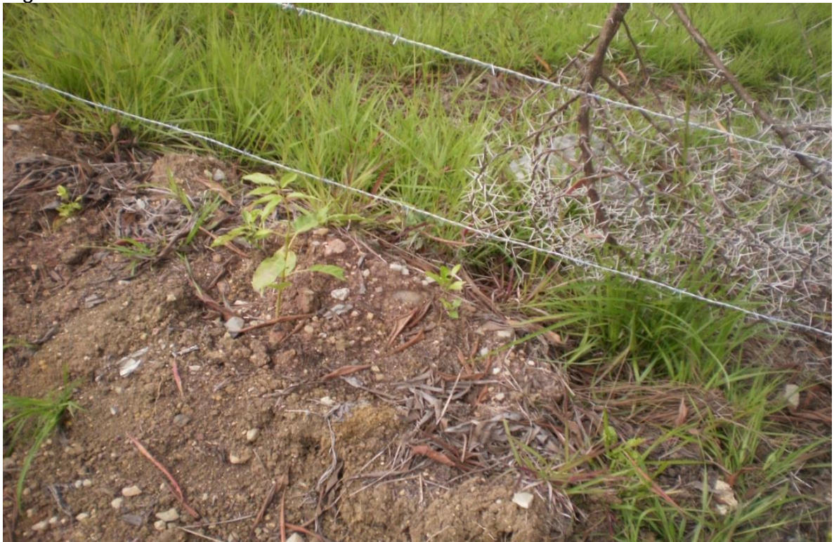
Figura 11. Fotos del Aislamiento
