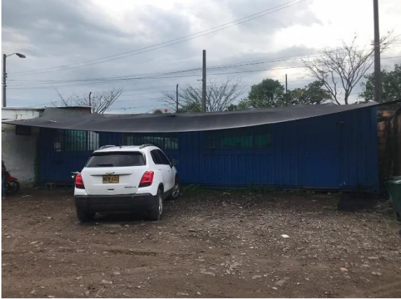
Figura 9. Exterior área administrativa, Tomada por Laura Linares, 2019
