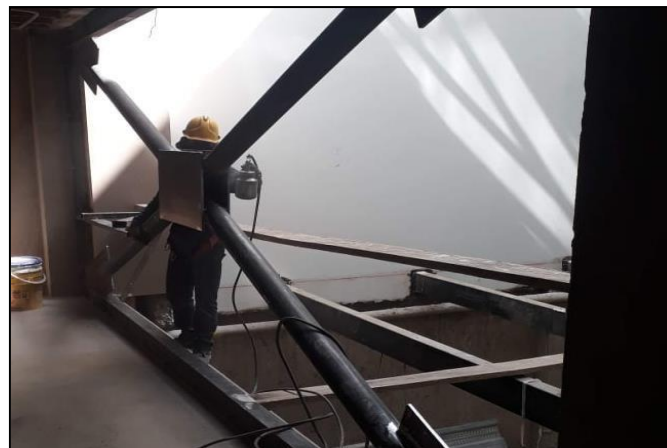
Fig. 7 Pintura en arriostramiento.[4].
