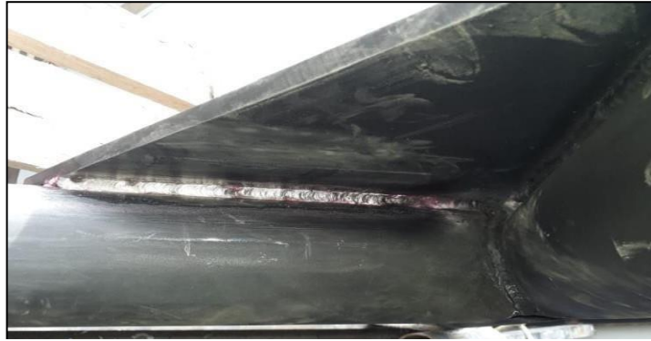
Fig. 6. Prueba de tinta a soldaduras. [4]
