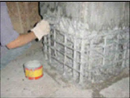
Figura 60 Procedimiento de tratamiento: puente de adherencia (Registrocdt.cl, 2013)
