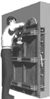
Figura 57 Procedimiento de tratamiento: vaciado de concreto (Emmons, 2012)
