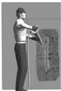
Figura 60 Procedimiento de tratamiento: demolición (Emmons, 2012)
