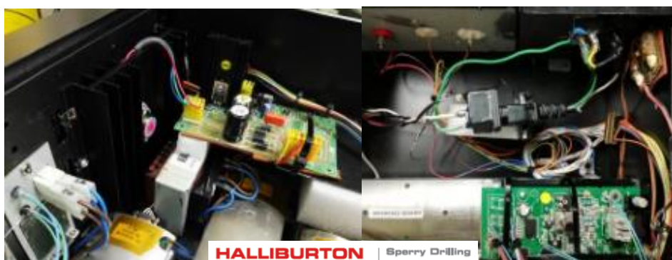
Figura 62. Adecuación interna final del prototipo
