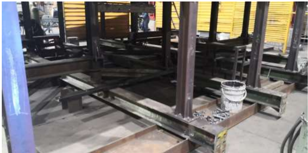
Figura 36. Pre-Montaje vista lateral
