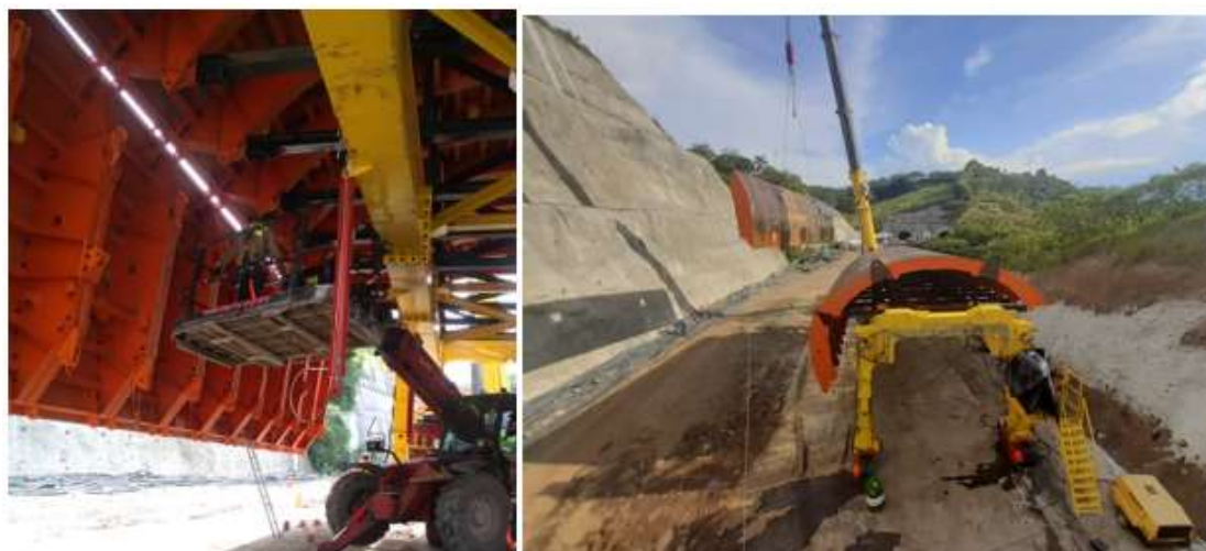
Figura 62. Izaje, paneles hastiales.
