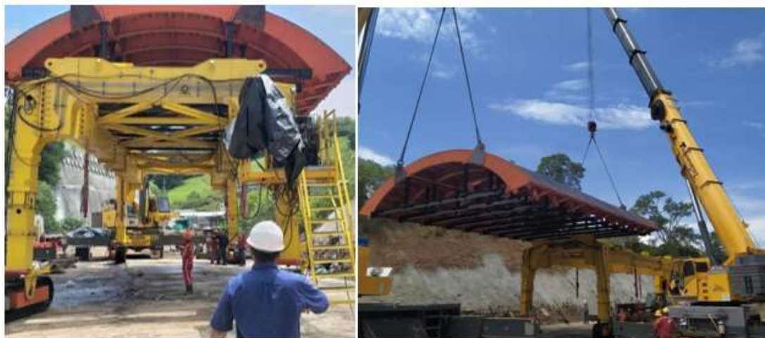
Figura 61. Izaje bóveda central, posicionamiento.
