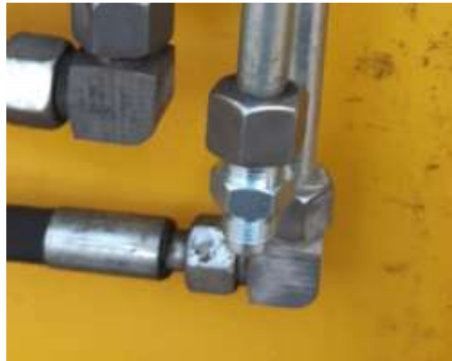
Figura 49. Prueba racor para unión de tubing a manguera.
