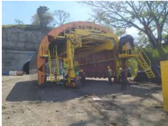
Figura 64. Verificación de encofrado.
