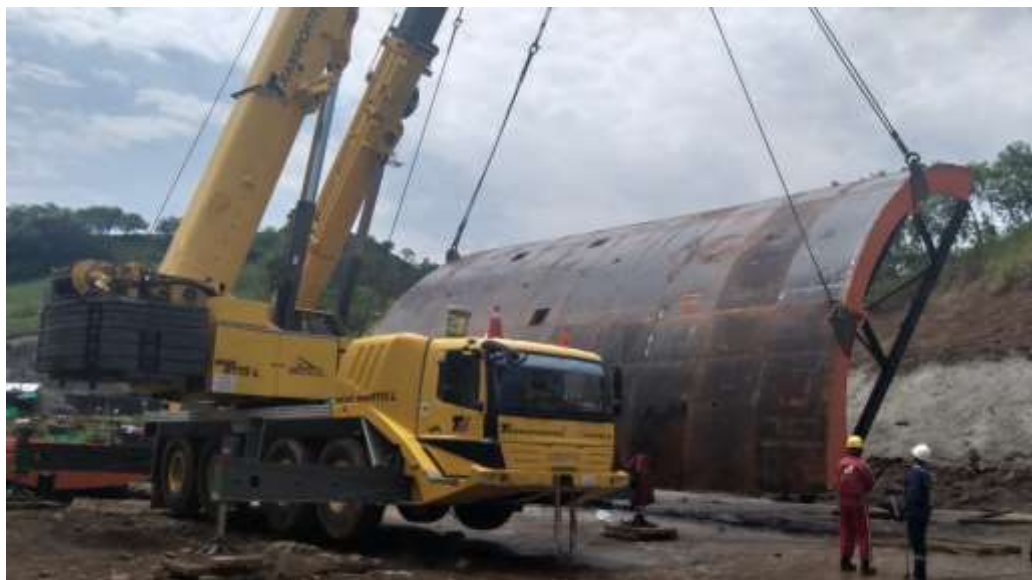
Figura 60. Izaje bóveda central.
