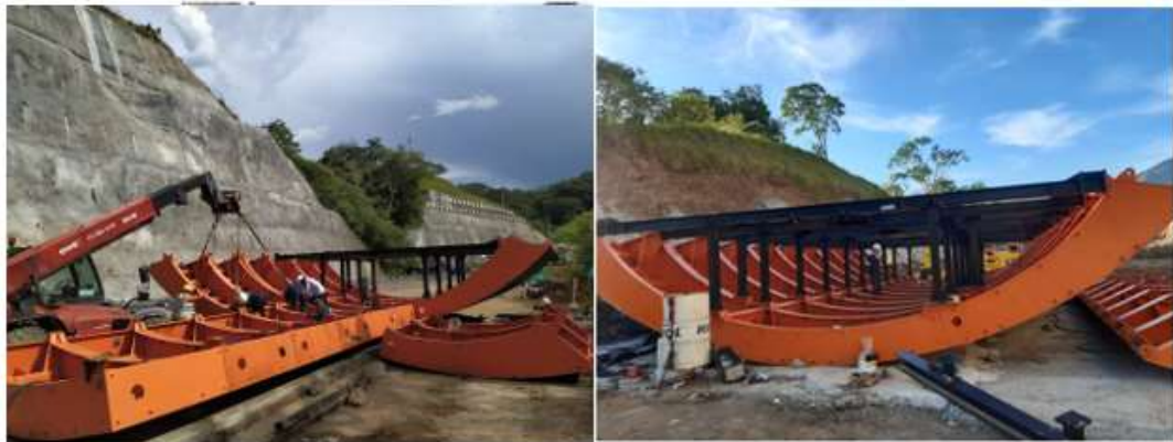
Figura 56. Montaje bóveda central.
