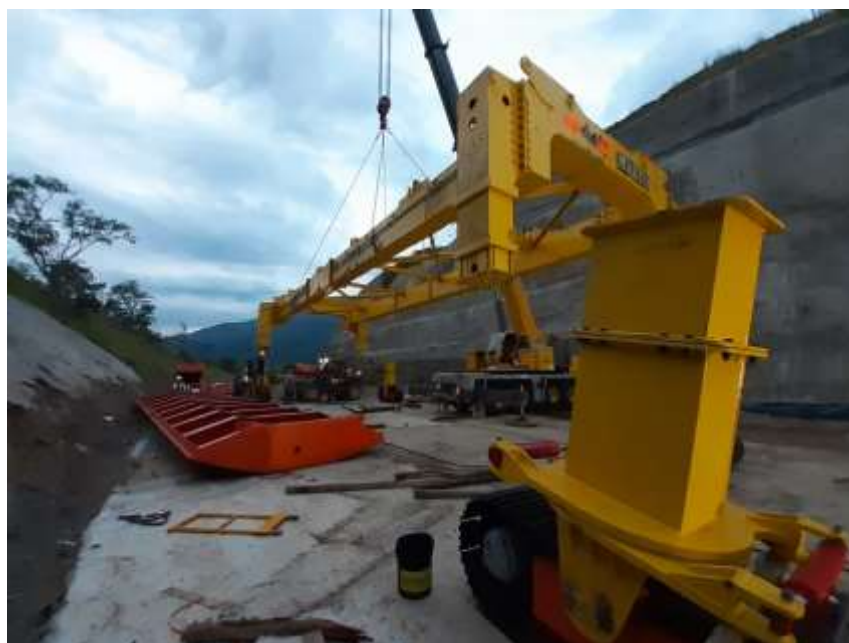
Figura 58. Izaje, carro de avance.
