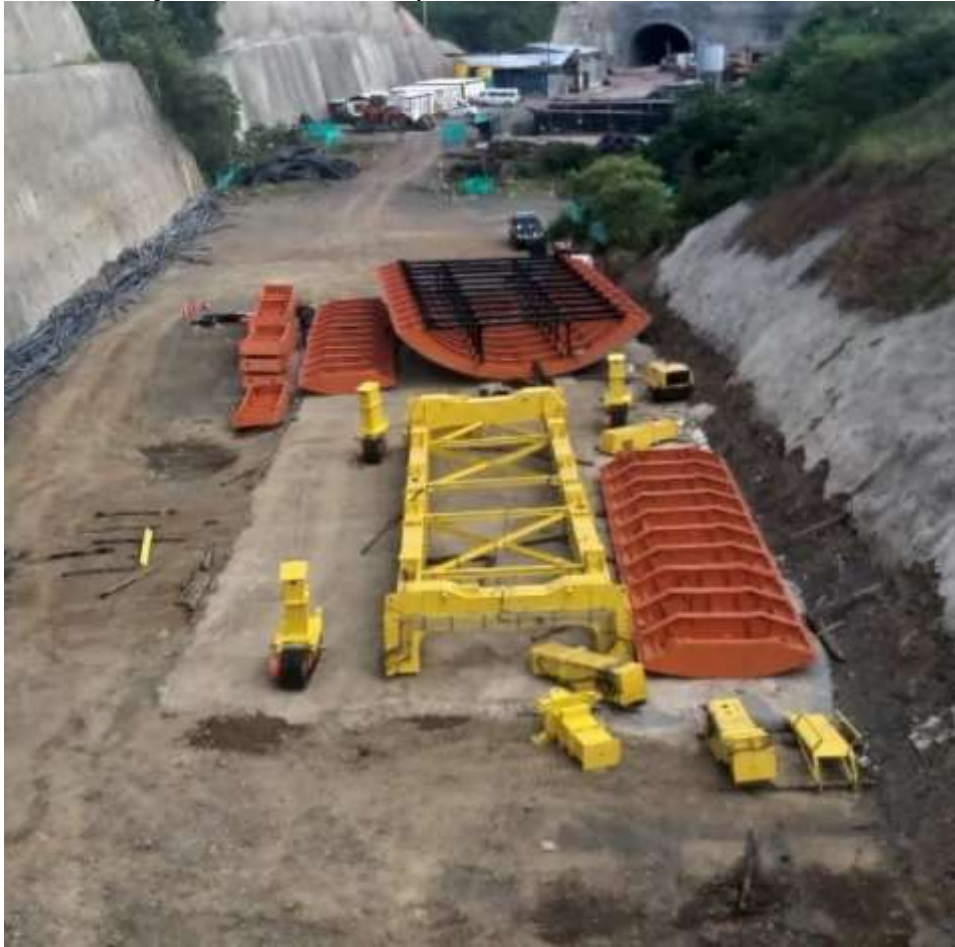
Figura 57. Montaje en obra vista superior.
