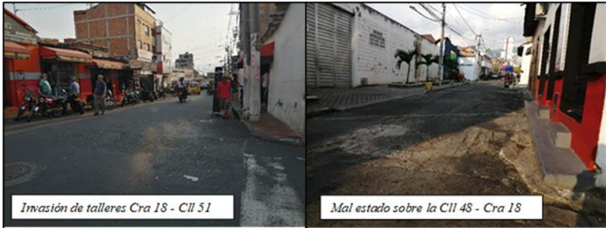
Figura 38. Estado calles del sector analizado.
