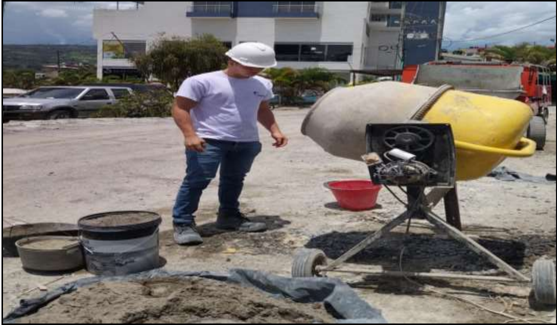
Fotografía 12. Elaboración de mezclas de concreto
