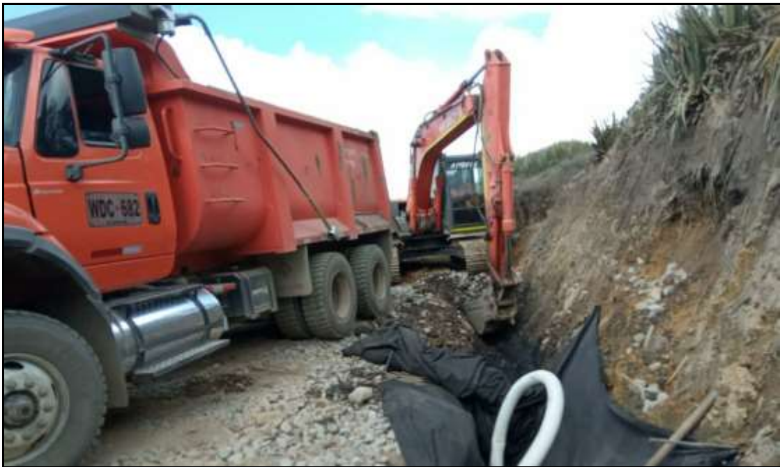
Fotografía 5. Realización de filtros PR 96+112
