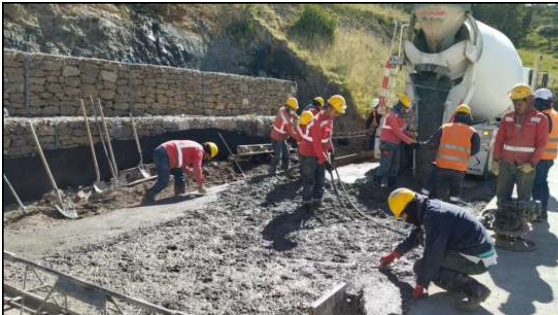
Fotografía 1. Pavimentación de vía en concreto PR 76
