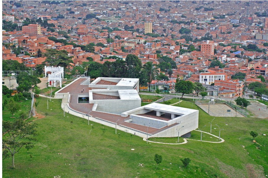
Figura 2. Vista general de La Ladera
