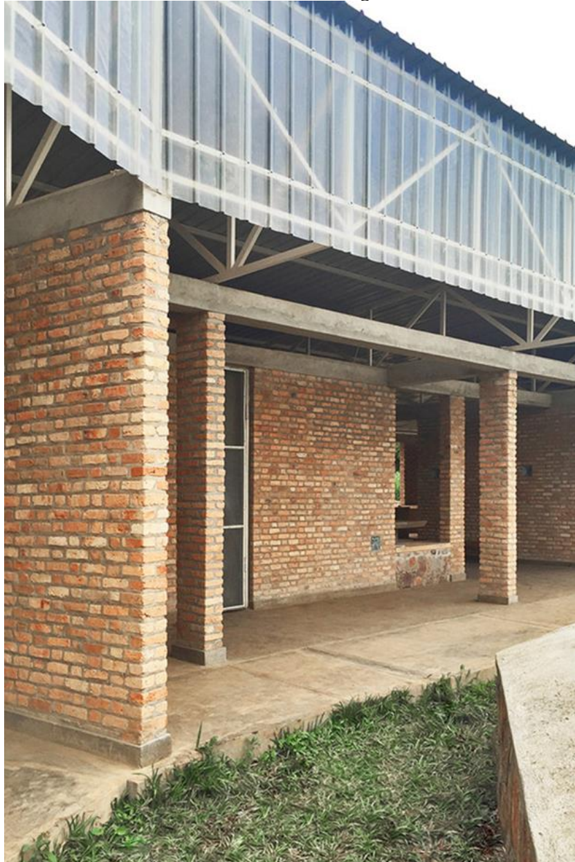
Figura 18. Dormitorios de la Escuela Luterana Rwamagana
