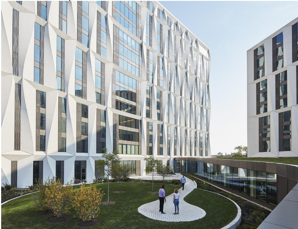
Figura 16. Materiales de fachada
