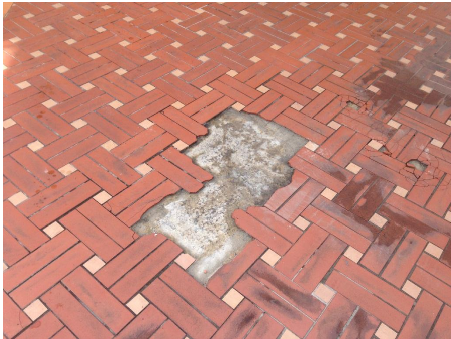
Fotografía 3-8 Piso del garaje edificio Consultorio Jurídico
