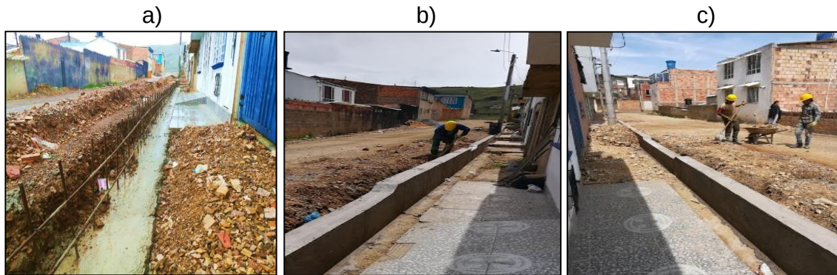
Ilustración 29: Fases de construcción del muro de contención.
