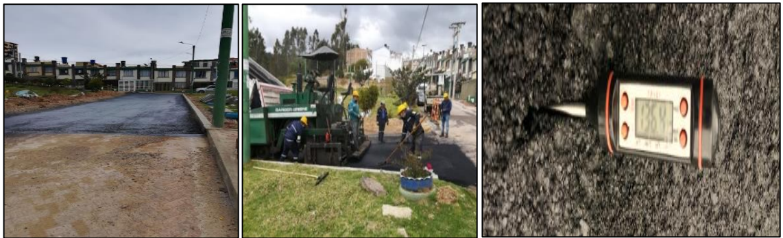
Ilustración 16: Conformación de la carpeta asfáltica.
