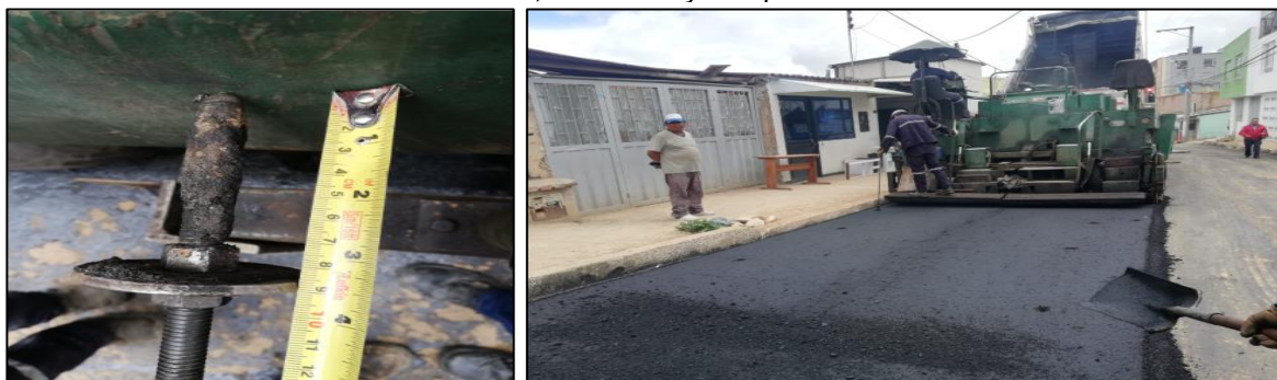
Ilustración 39: Suministro, extendida y compactación de la C.A.
