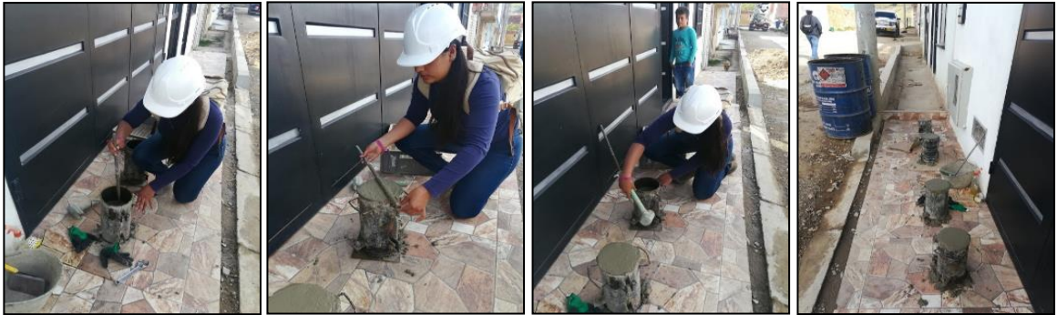
Ilustración 30: Elaboración de camisas de concreto.
