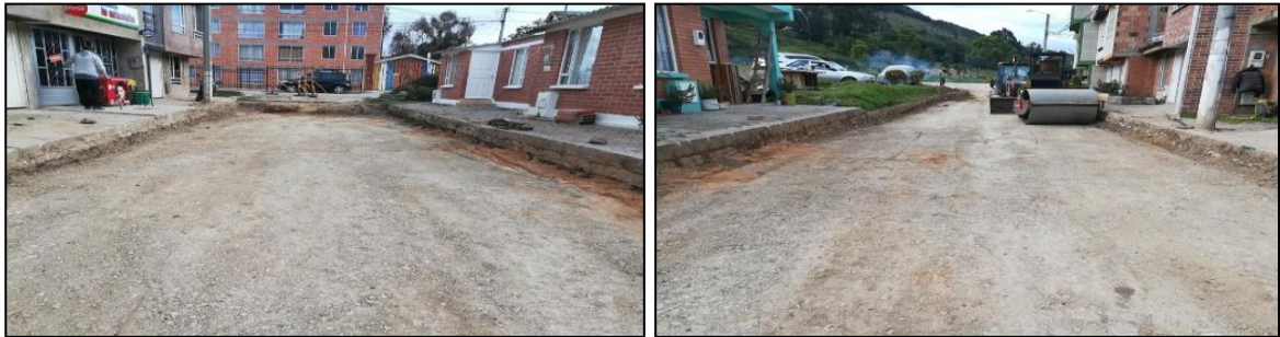
Ilustración 19: Extendida y compactación mejoramiento subrasante.
