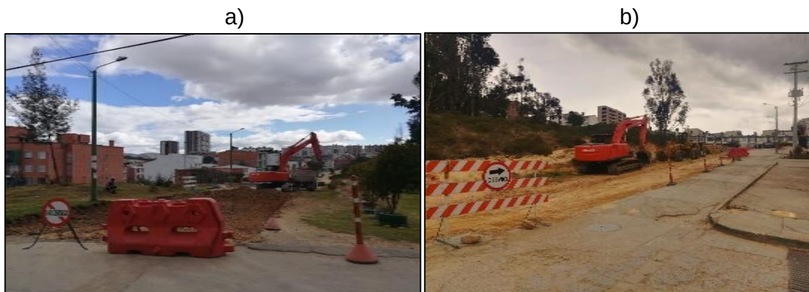
Ilustración 12: Excavación mecánica de la vía Palos Verdes.
