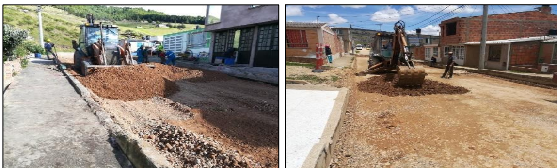
Ilustración 5: Extendida de SBG.
