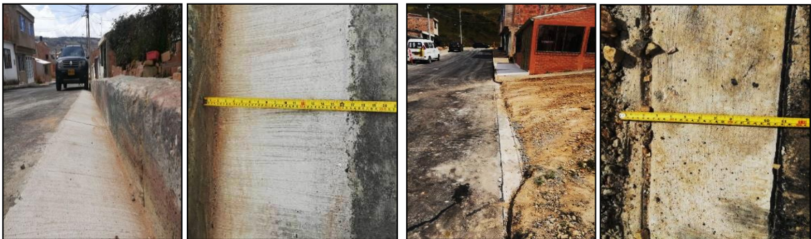
Ilustración 11: Verificación de dimensiones cuneta y vigas.
