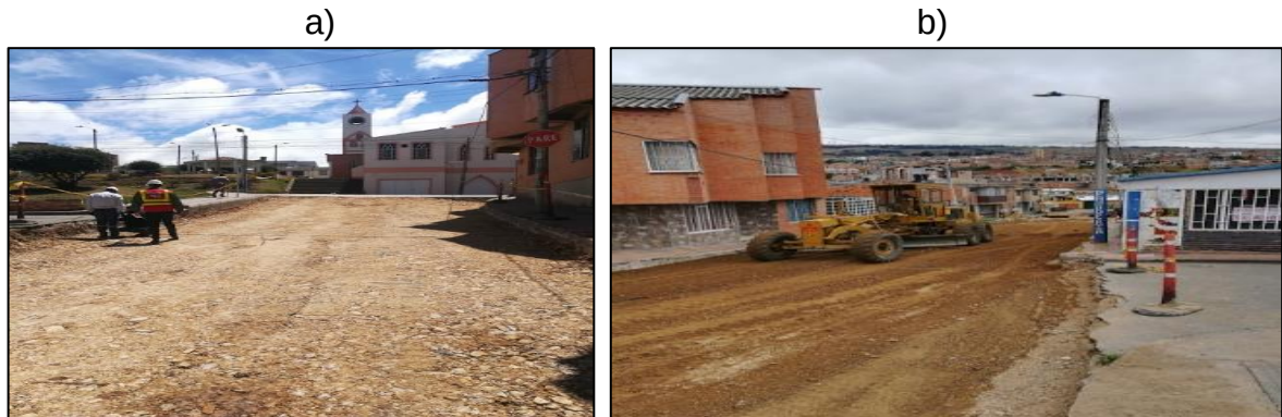
Ilustración 41: Conformación de afirmado y SBG.
