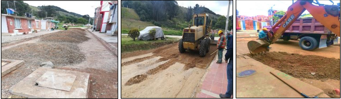
Ilustración 22: Extendida y compactación de BG.
