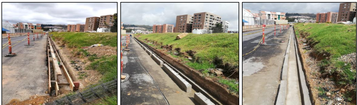
Ilustración 36: Fundida paredes canal y estado final.
