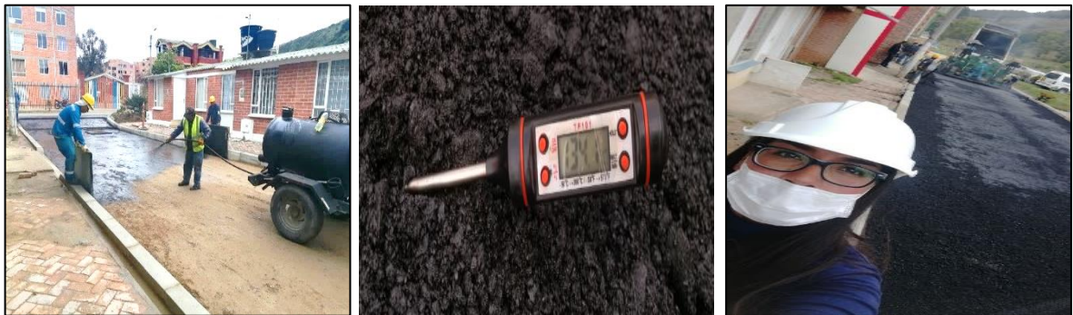
Ilustración 25: Actividades del asfalto MDC-19.
