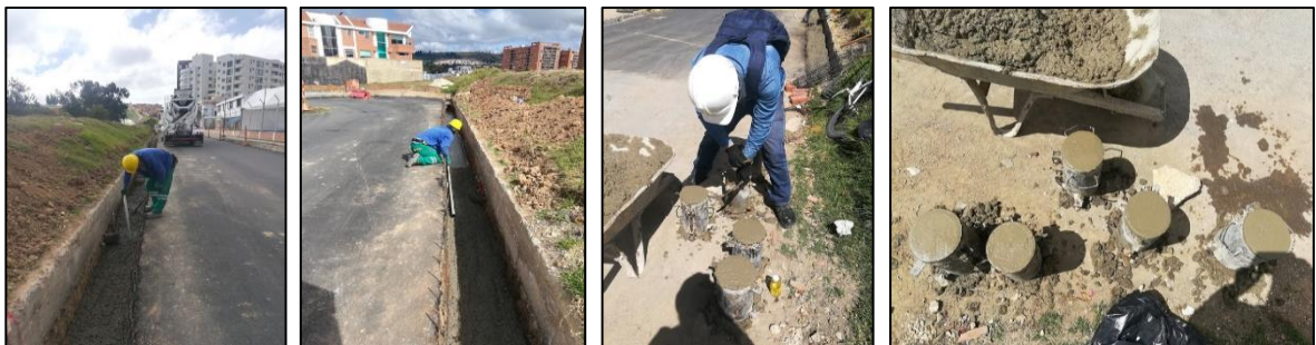
Ilustración 35: Fundida base canal y elaboración de cilindros de concreto.
