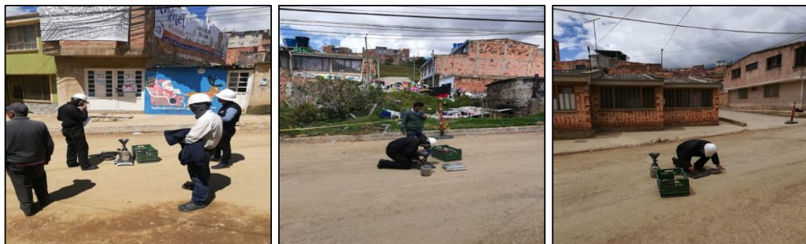
Ilustración 38: Densidades mediante el ensayo cono y arena.
