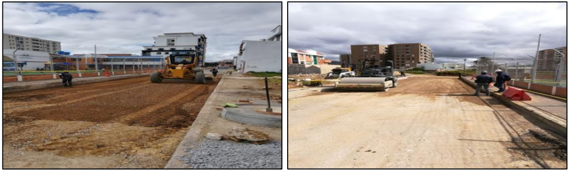
Ilustración 32: Actividades realizadas en la excavación.
