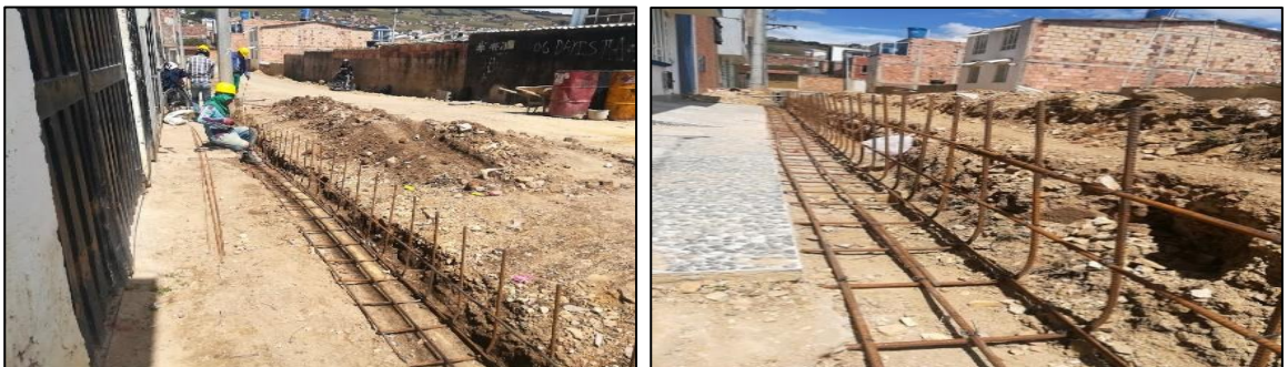
Ilustración 27: Armado de acero.
