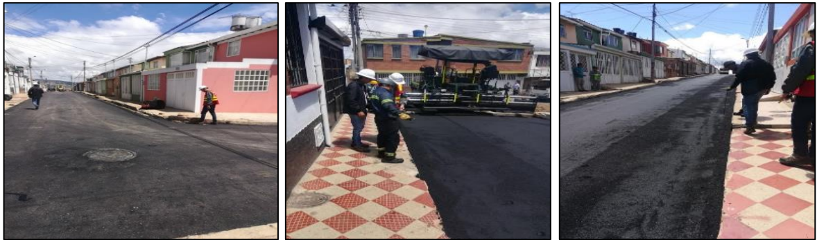
Ilustración 43: Suministro, extendida y compactación de la C.A.
