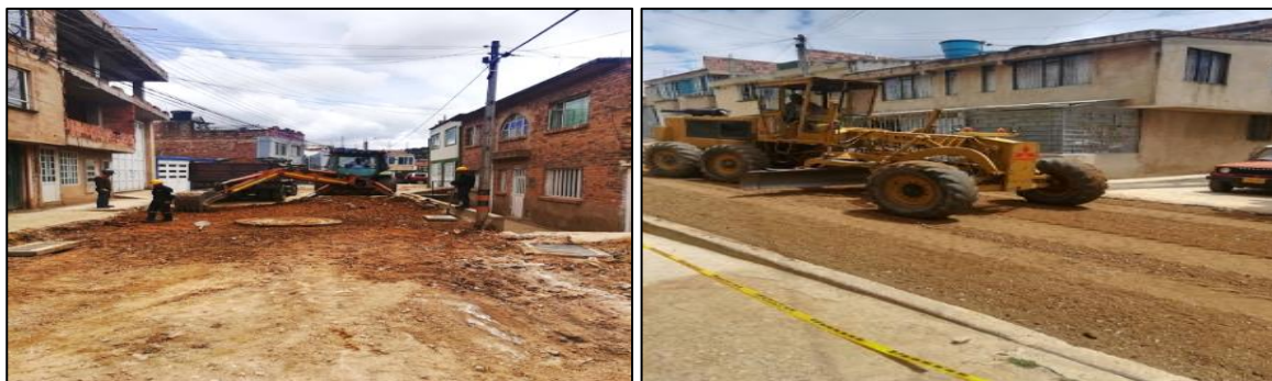
Ilustración 37: Demolición de C.A. y extendida de BG.
