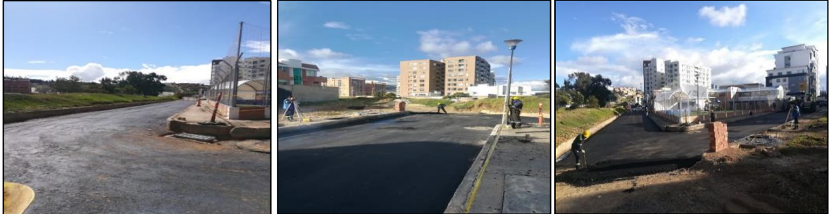
Ilustración 33: Actividades realizadas en la excavación.
