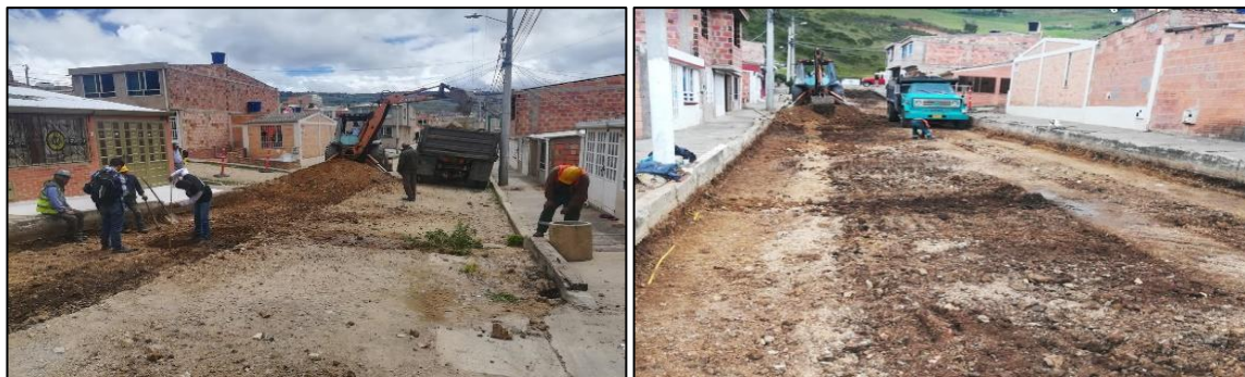
Ilustración 4: Excavación mecánica.
