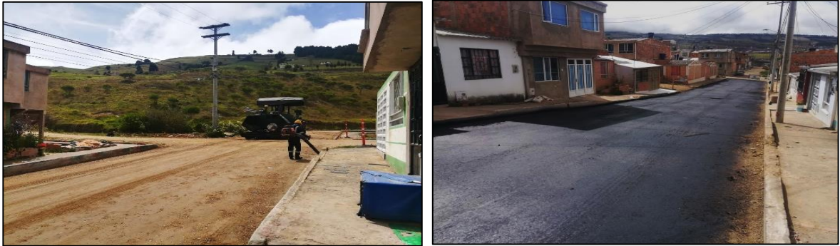
Ilustración 9: Soplado e imprimación CRL-1h.
