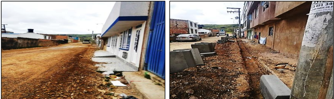
Ilustración 26: Conformación de material de afirmado y sardinel.
