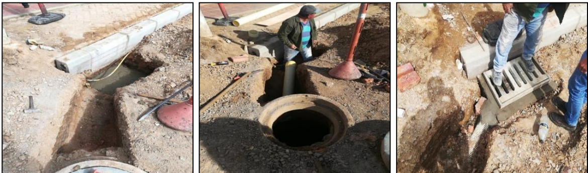
Ilustración 23: Construcción sumidero.
