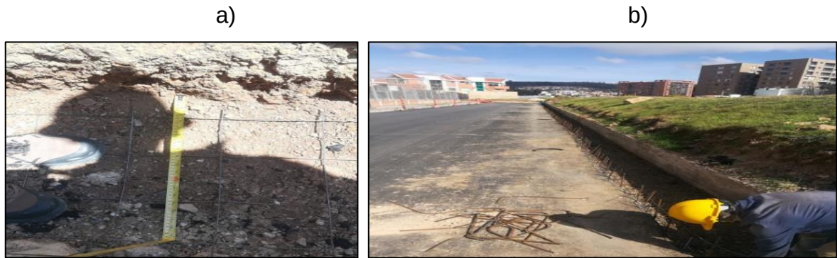
Ilustración 34: Verificación de las medidas de diseño del canal.
