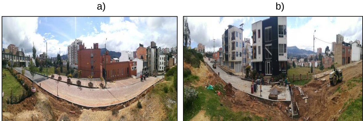
Ilustración 18: Estado final de la vía Palos Verdes.
