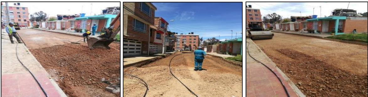
Ilustración 20: Extendida y compactación de SBG.
