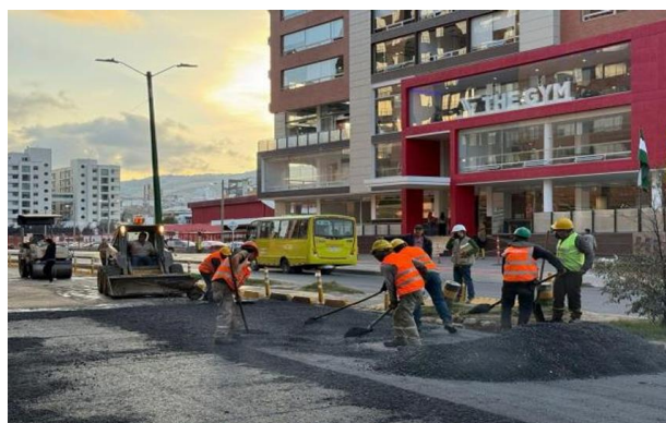
Figura 17 Supervisión extendida de mezcla asfáltica
