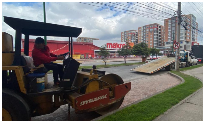
Figura 22 Traslado de Maquinaria
