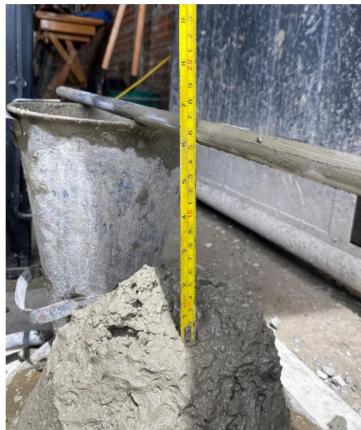
Figura 33 Prueba de asentamiento del concreto
