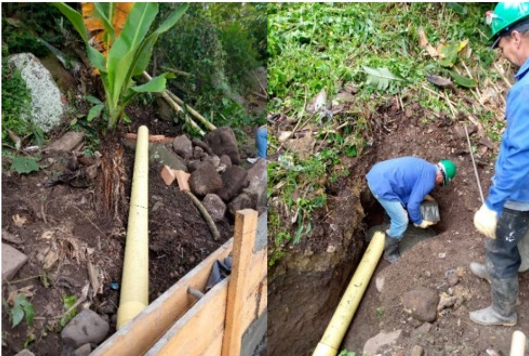
Figura 25 Suministro e instalación tuberías PVC alcantarillado para domiciliarias.
