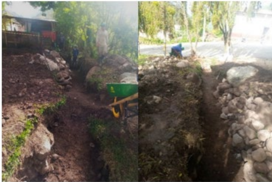
Figura 21 Excavaciones a mano en material duro y/o conglomerado en zanjas 0 < h < 1.2 m
