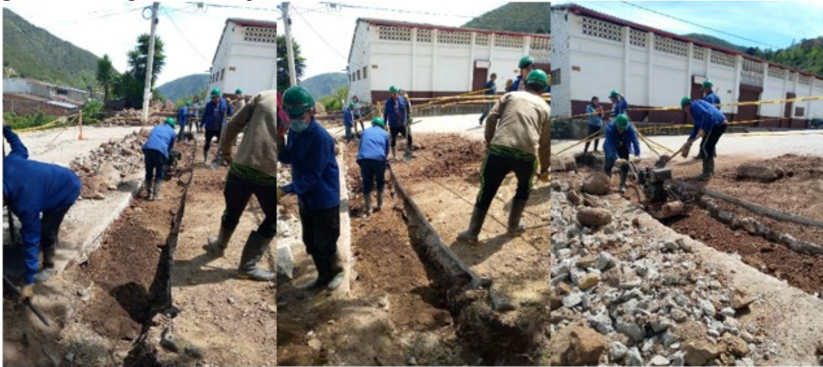
Figura 33 Base granular compactada.
