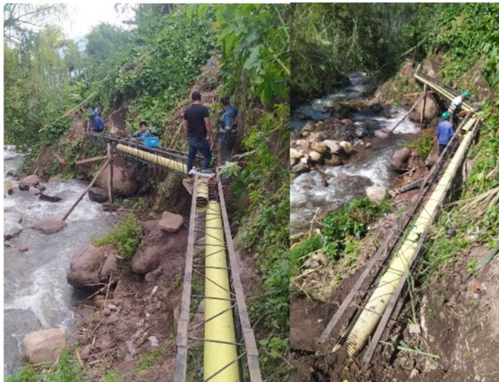
Figura 36 Instalación de cercha metálica.
