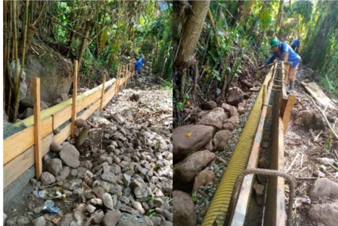
Figura 35 Construcción de muro ciclópeo.
