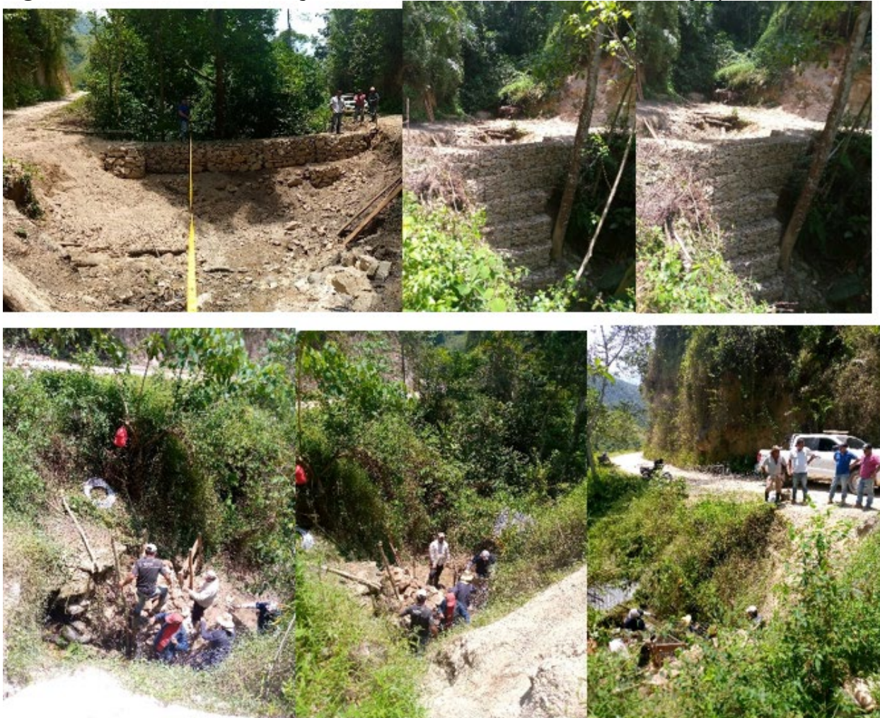
Figura 15 Visita técnica a obra que se está adelantando en la vereda La Explayada
