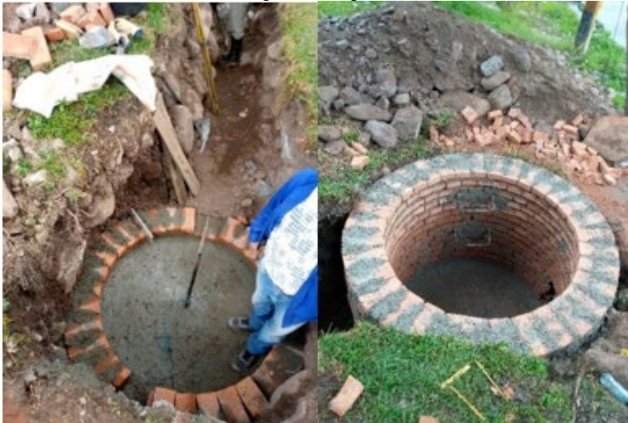
Figura 30 Construcción de Cámara de Inspección tipo I en ladrillo h < 2 m.
