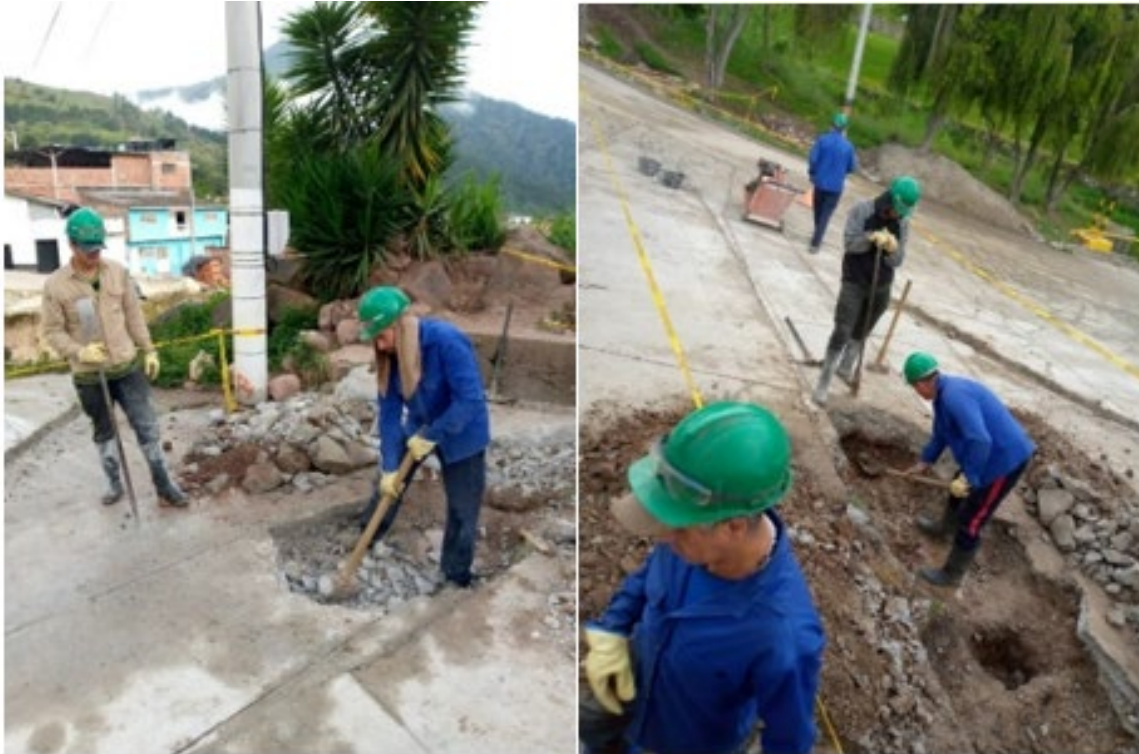
Figura 32 Demolición de pavimento en concreto.
