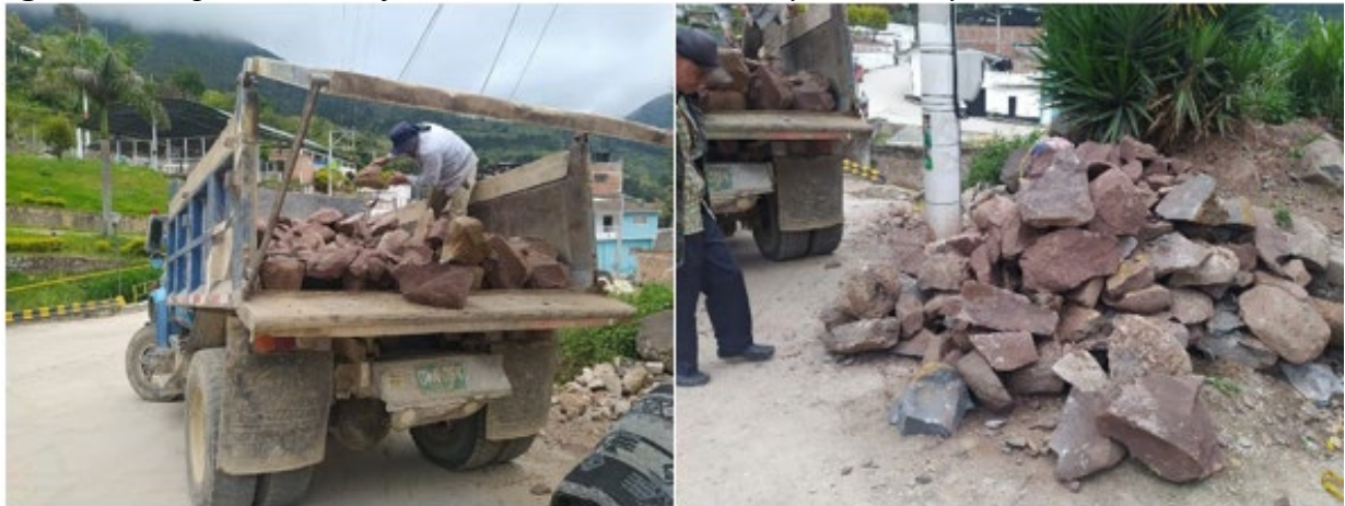
Figura 24 Limpieza, Desalojo de material sobrante incluye acarreo y escombro.
