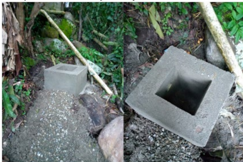
Figura 28 Suministro y construcción de caja de inspección en ladrillo.
