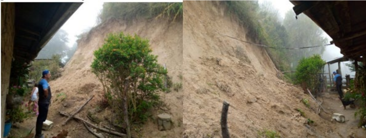
Figura 18 Visita de inspección ocular a vivienda ubicada en la vereda las américas
