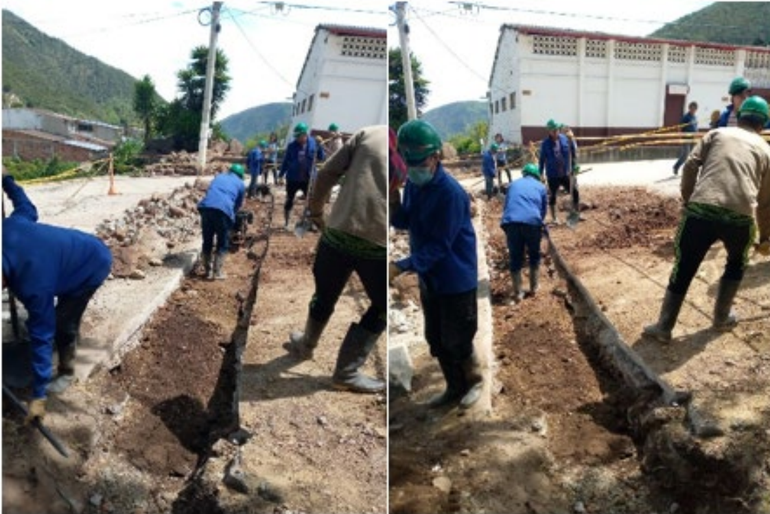
Figura 23 Relleno con material común misma excavación.
