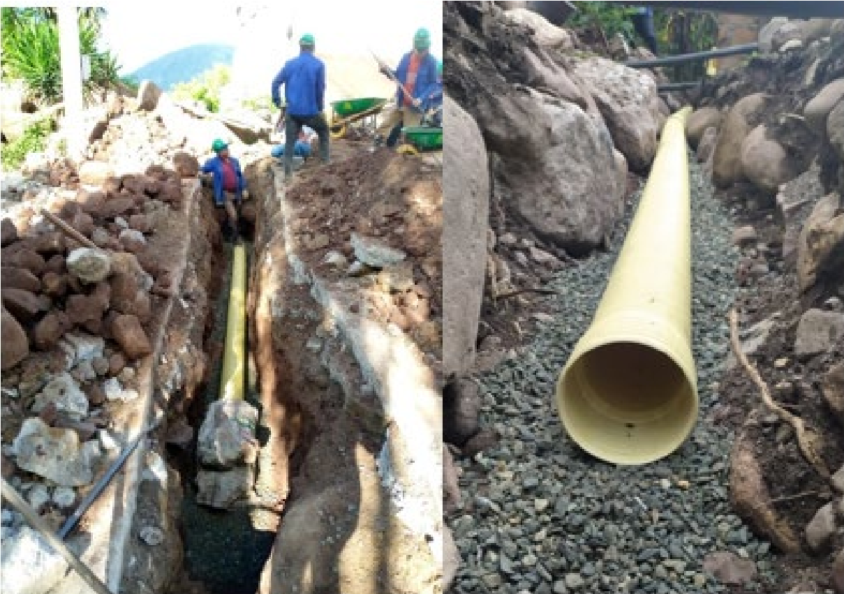
Figura 26 Suministro e instalación tuberías Alcantarillado tipo PVC Ø8"
