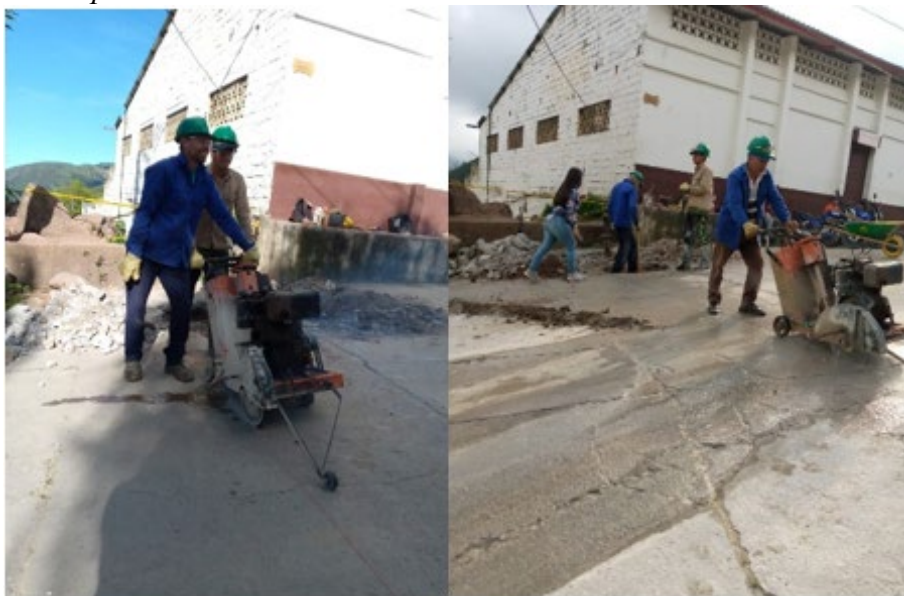
Figura 31 Corte de pavimento en concreto
