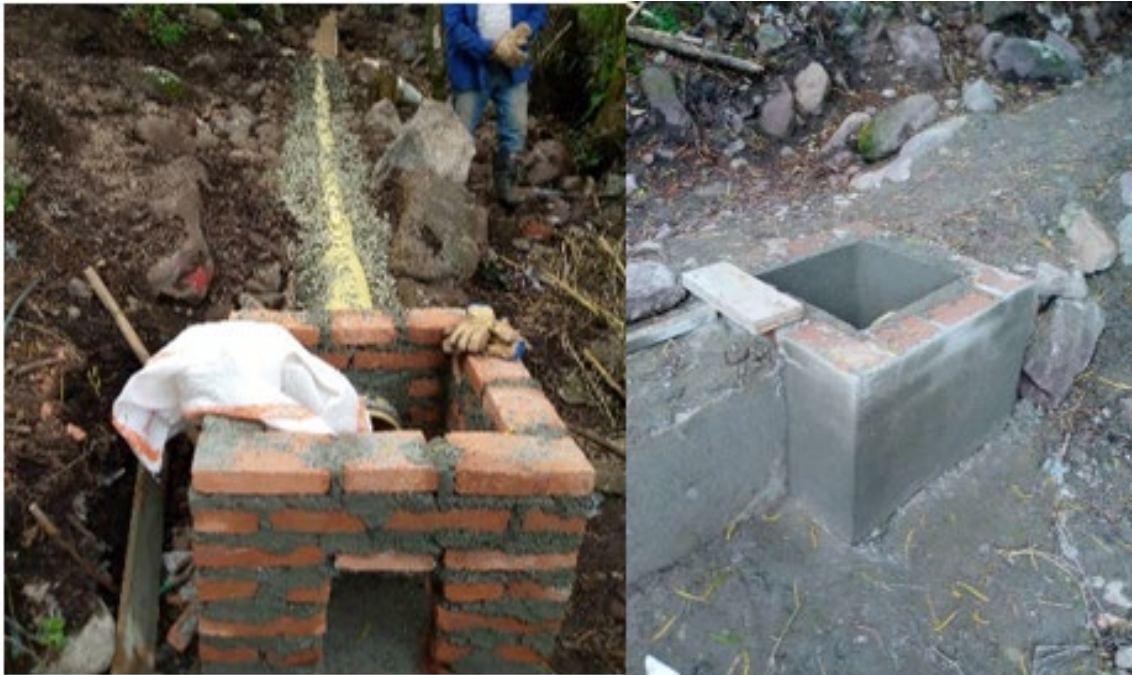
Figura 29 Suministro y construcción de caja de inspección en ladrillo de 70cm x 70cm.
