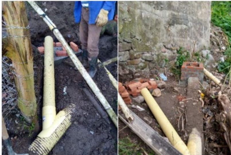
Figura 27 Suministro e instalación de Silla Yee 8"x6", (200X160)
