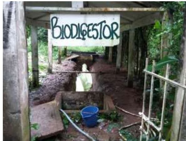
Figura 5. Instalación del biodigestor tubular en el Colegio Agrícola Guacavía
