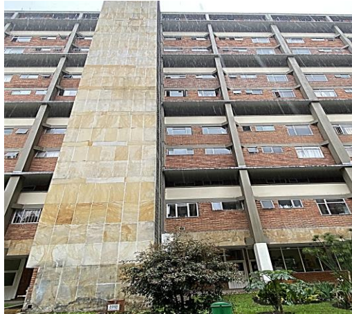
Ilustración 6. Suciedad por lavado diferencial. Autores.
