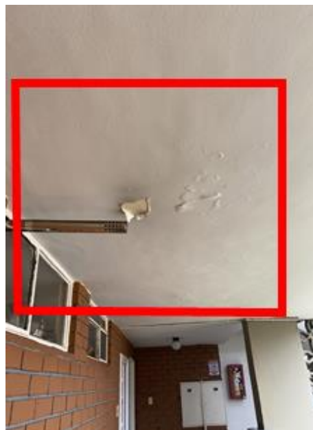
Ilustración 5. Suciedad por depósito. Autores.
