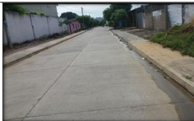
Figura 9 Pavimento rígido en las calles 9 y 8 del barrio 20 de Julio (fuente: Propia)
