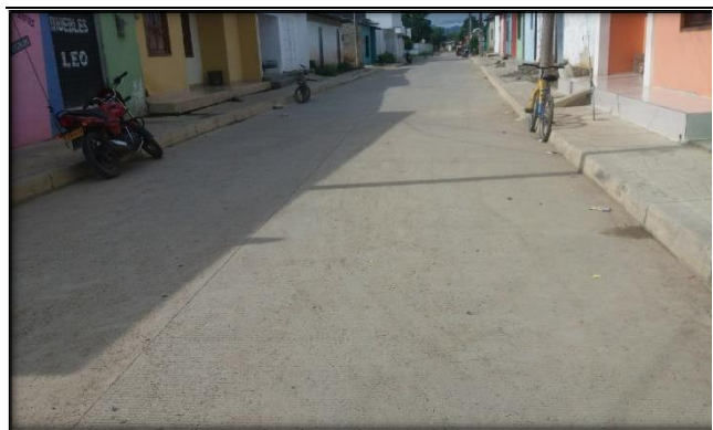
Figura 8 Intervención de pavimento rígido en el barrio 20 de Julio (fuente: propia).
