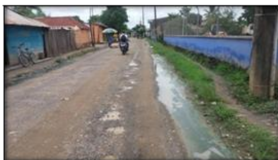
Figura 3 Aguas lluvias acumuladas en la calle 12- Barrio 19 de Marzo (fuente: autoría propia)
