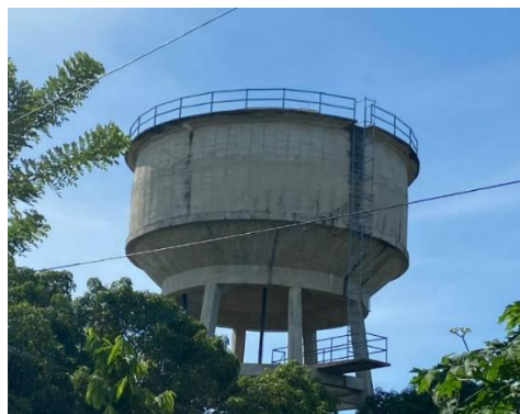
Fotografía 1 Tanque elevado de almacenamiento de agua “Guayabal” Fuente: propia
