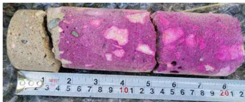
Fotografía 28 — Ensayo de carbonatación
