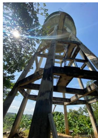
Fotografía 2 Tanque elevado de almacenamiento de agua “Guayabal” Fuente: propia
