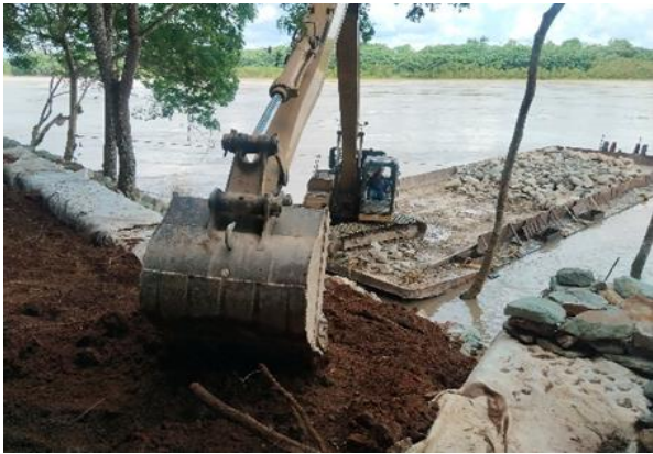
Actividad Excavación Mecánica en Conglomerado
