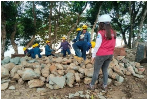
Figura 13. Actividad Suministro e Instalación Enrocado
