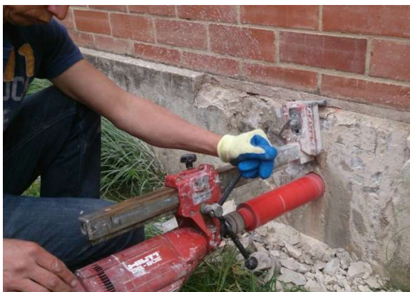
Foto 4. Detalle de la extracción de núcleos en la viga de amarre. (Fuente Elaboración propia).
