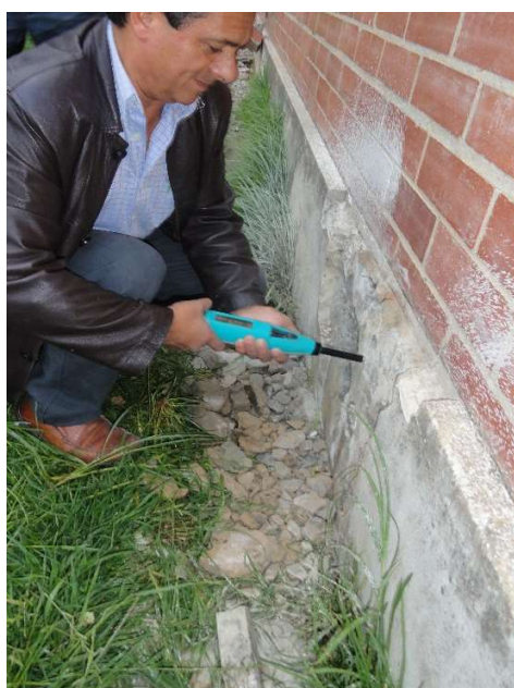
Foto 3. Pruebas de Esclerometría en Viga de amarre. (Fuente Elaboración Propia).
