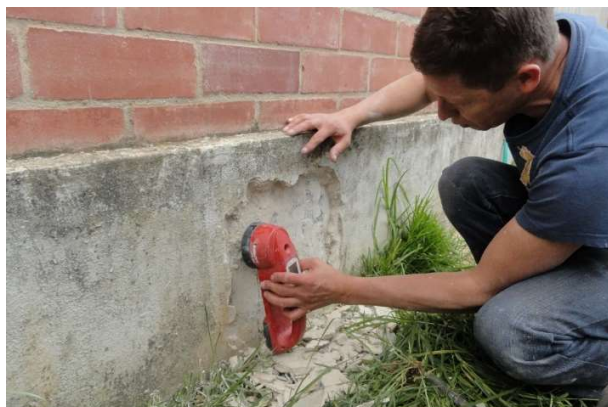
Foto 2. Detección acero de refuerzo. (Fuente Elaboración propia).
