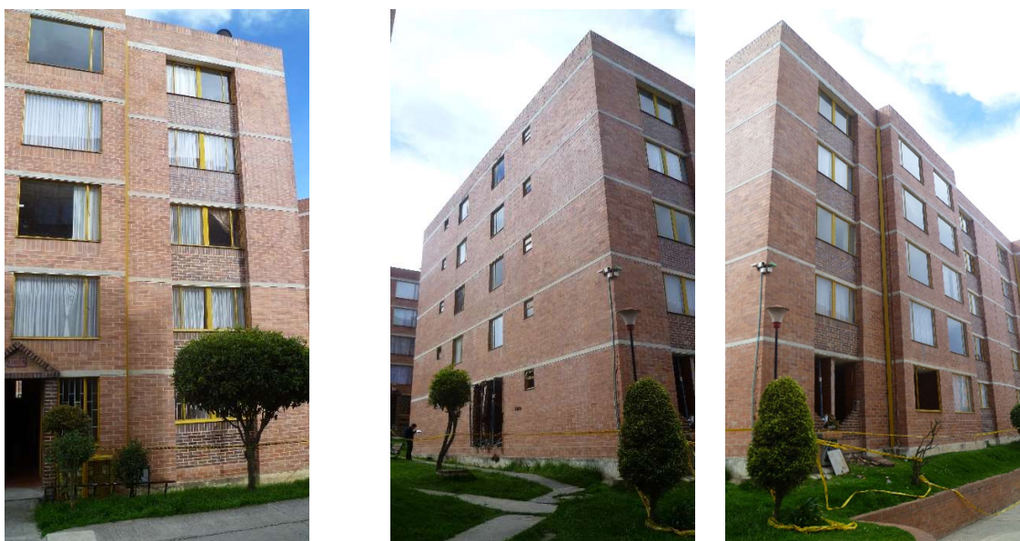
Foto 1. Estado exterior del bloque 8. (Fuente elaboración propia).
