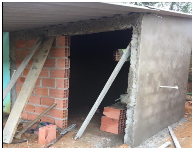
Imagen 2. Visita a obra en avance del 60%.
