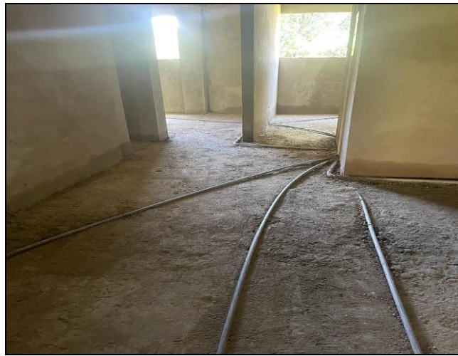
Imagen 4. Verificación de avance de obra.
