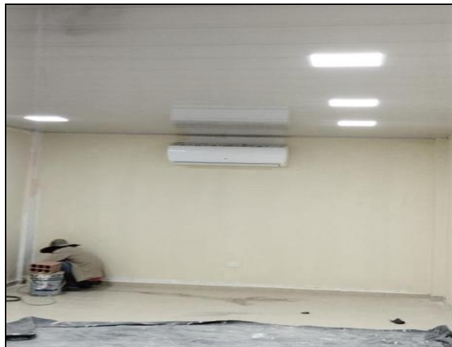
Imagen 13. Verificación de avance de obra.
