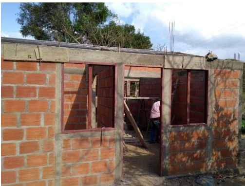
Foto 8. Viga aérea en uno de los proyectos.
