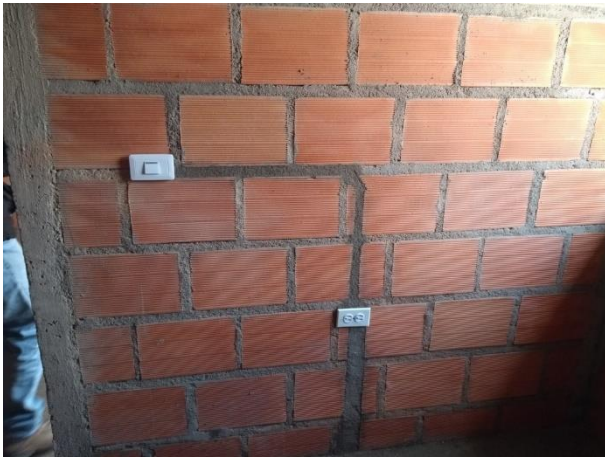
Foto 39. Punto eléctrico 110 V en uno de los proyectos.
