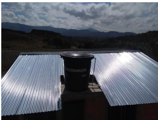
Foto 27. Cubierta en zinc en uno de los proyectos.
