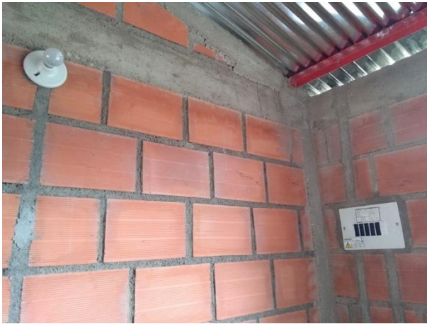
Foto 35. Caja de circuitos en uno de los proyectos.
