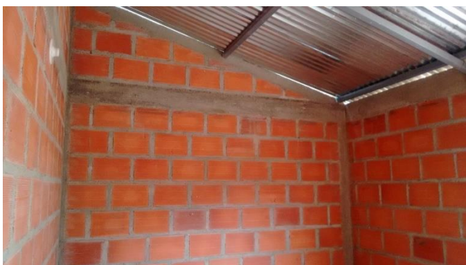
Foto 26. Cubierta en zinc en uno de los proyectos.
