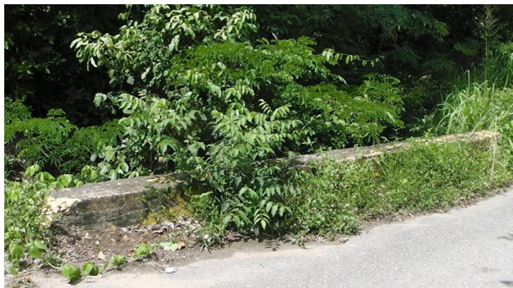
Figura 19 Vista general del pontón K6+996
