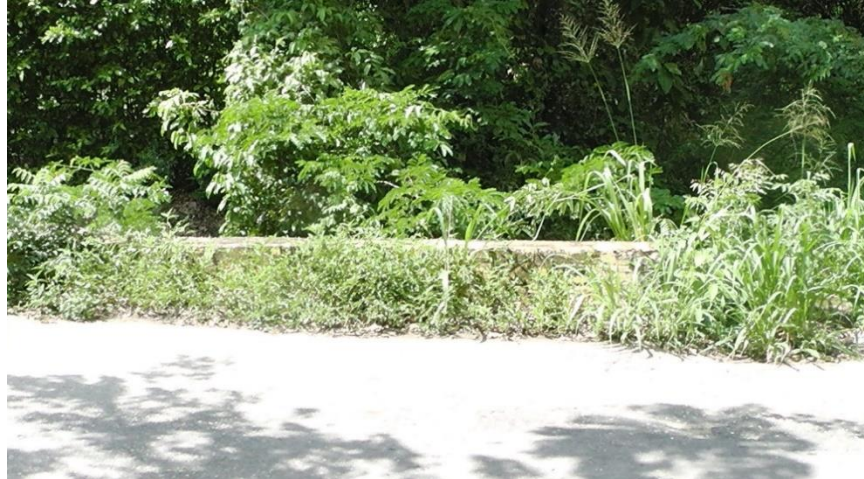
Figura 22 Bordillos puente K6+996
