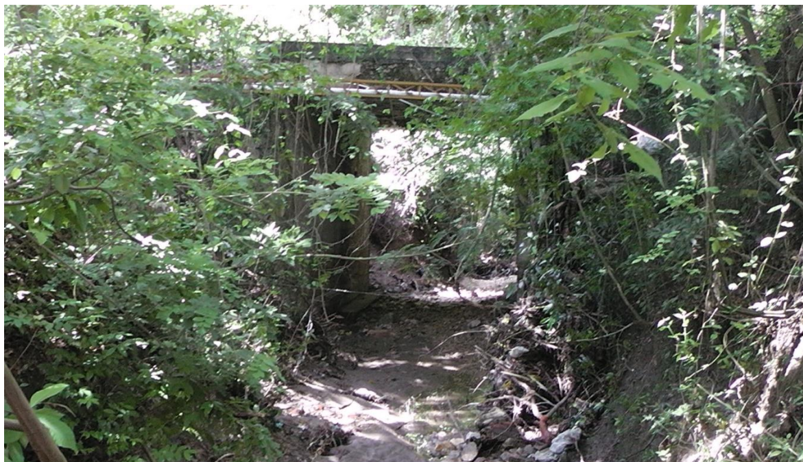
Figura 26 Losa puente K6+996
