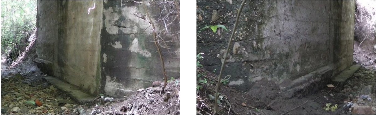
Figura 23 Aletas puente K6+996
