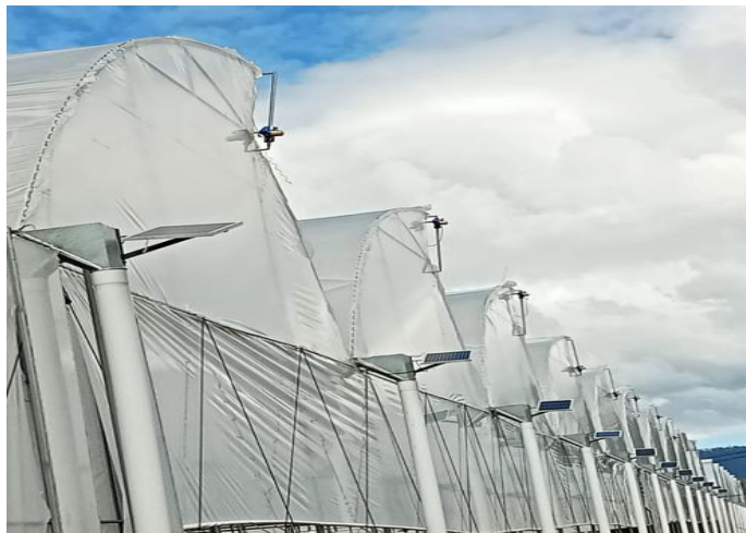
Figura 67 Instalación Del Sistema En Las 14 Naves Del Invernadero
