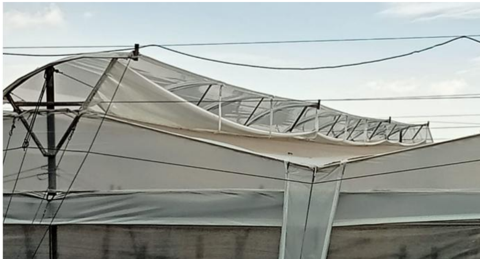
Figura 3. Sistema De Ductos Abierto.
