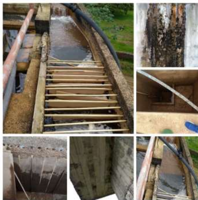
Figura 2. Estado de la planta de tratamiento de agua potable del municipio de Carurú.
