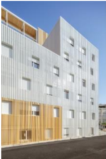
Figura 4. Detalle de fachada.
