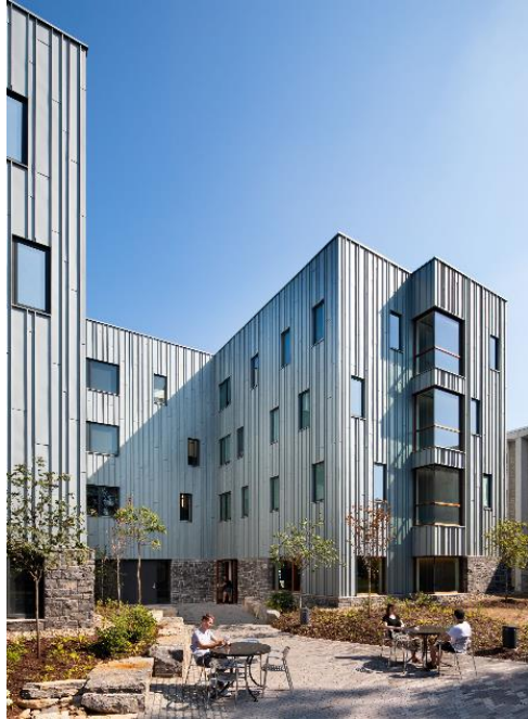
Figura 8. Detalle vacío interno de fachada.
