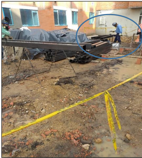
Fotografía 2: Detalle del proceso de pintado de perfilería. Nótese a la izquierda de la imagen Fuente: propia
