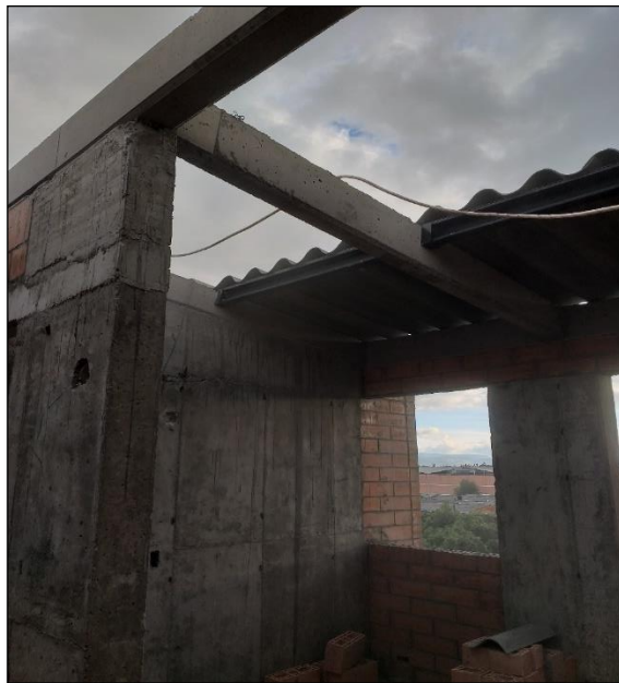
Fotografía 4. Teja instalada sobre perfilería, viga y cuchilla. Fuente propia
