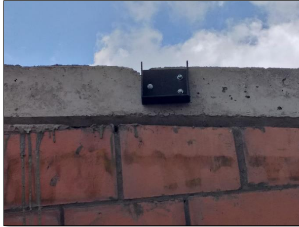
Fotografía 1. Detalle de zapatería instalada en obra Venti. Fuente: propia
