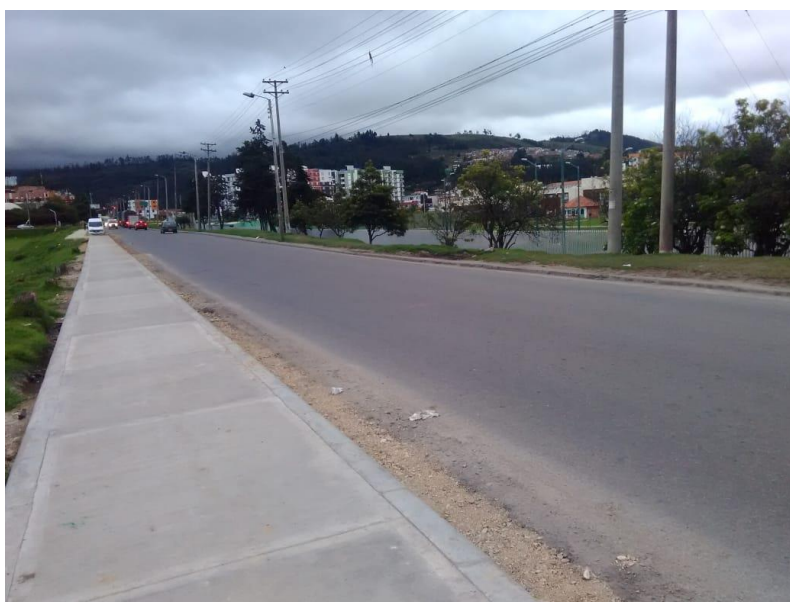
Figura 11. Ruta 62 vía Tunja-Bucaramanga. Fuente: Autor propio
