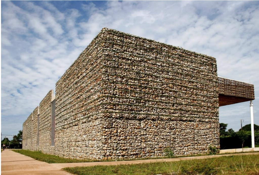
Figura 2. Biblioteca Pública de Villanueva (Villanueva, Casanare). Fuente:
