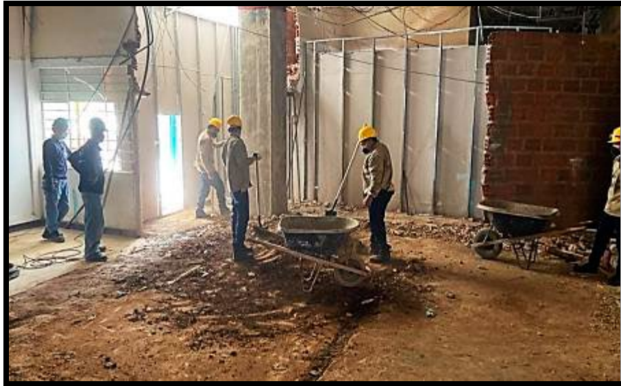
Figura 16. Adecuación de terreno.
