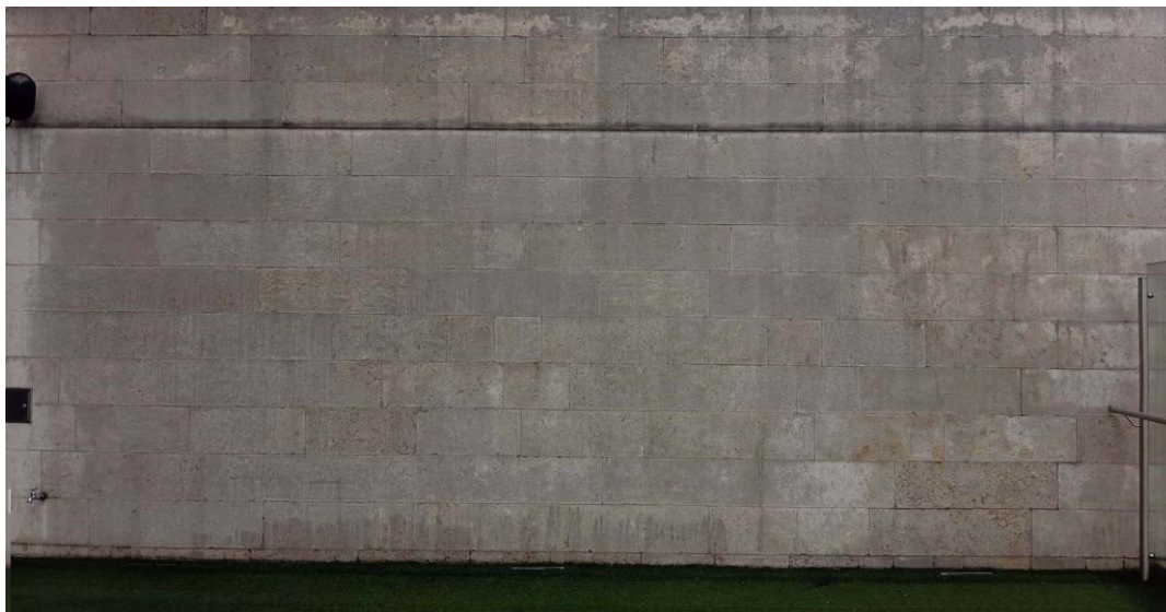
Ilustración 10. Fotografías de muros actuales del edificio doctor angélico
