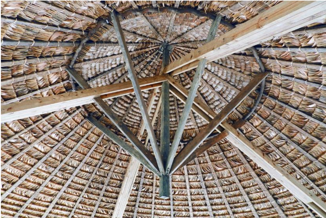
Figura 35: Estructura de la cubierta
