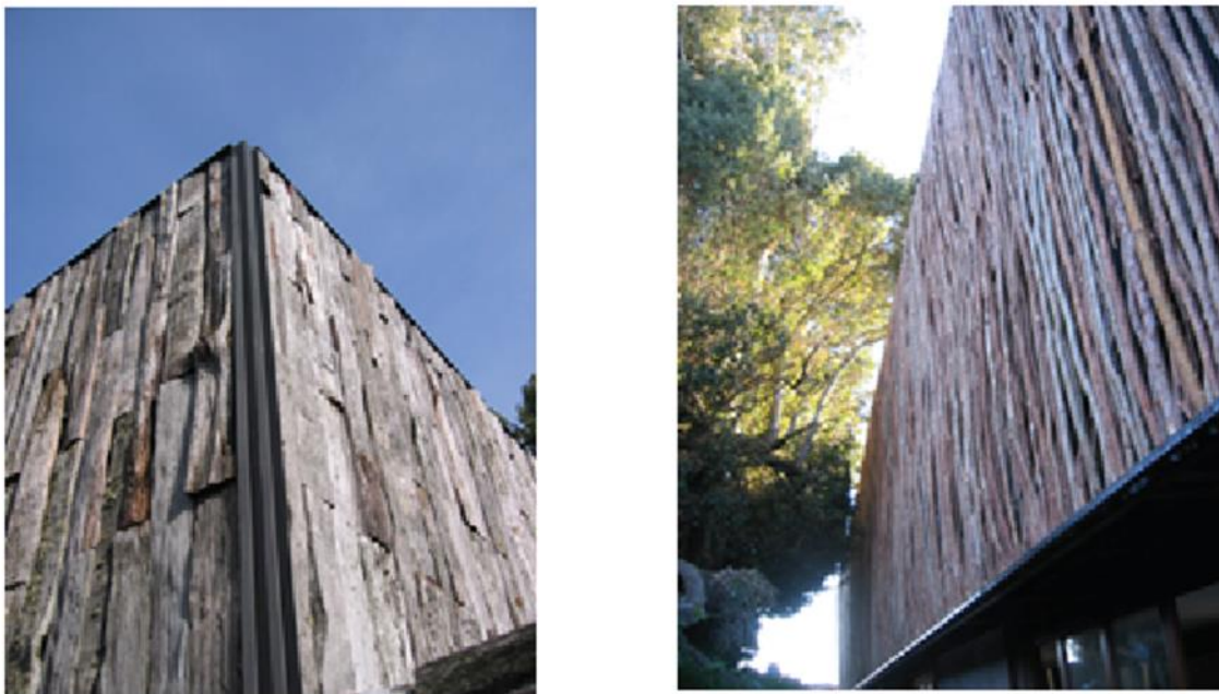
Figura 25: Acabado de la fachada en madera
