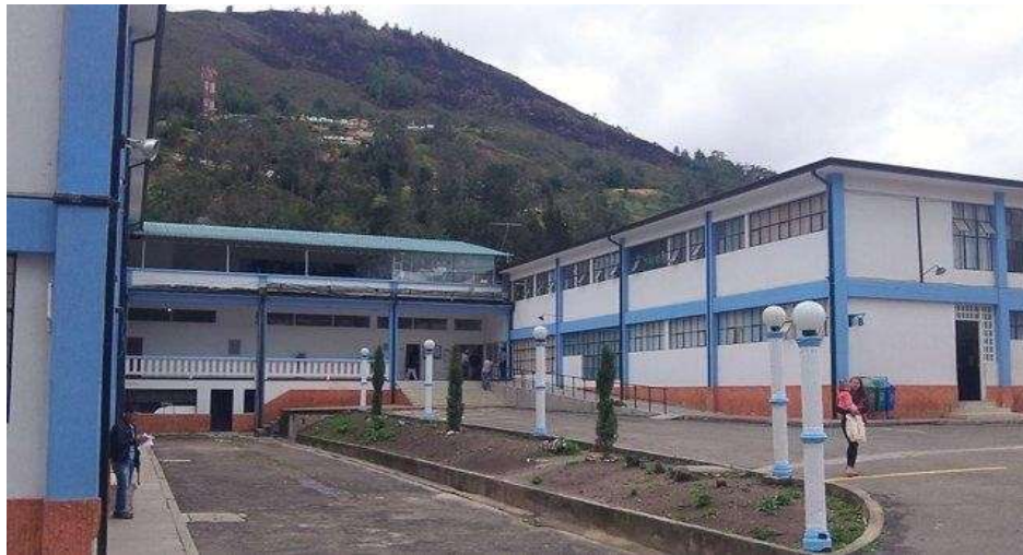
Figura 3 Vista del interior del lote hospital, acceso principal al establecimiento de salud
