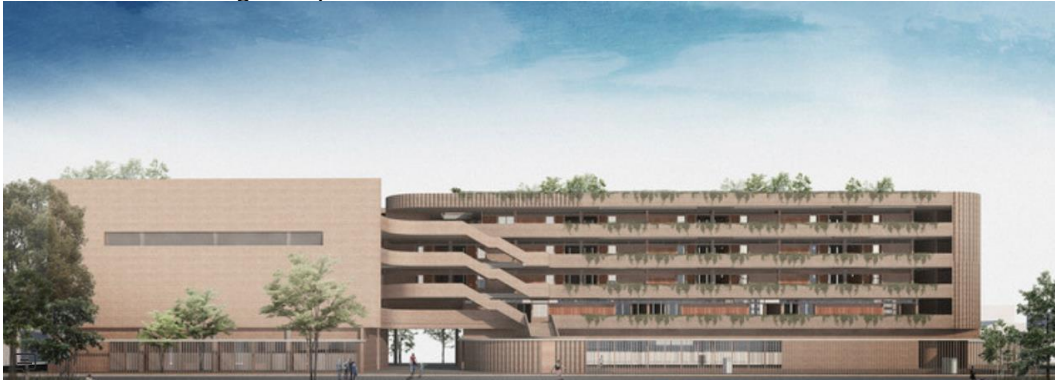
Figura 19. Fachada Colegio Hipotecho.
